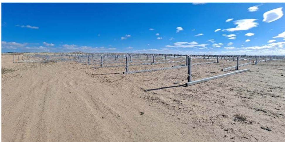
Figura 8.1. Avance en el montaje de las estructuras de soporte
