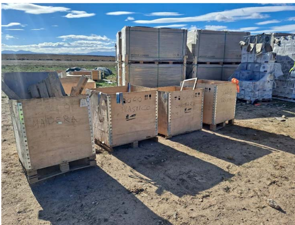
Figura 8.5. Cajones instalados para la recogida de los residuos en la vecina planta "San Pedro A", antes de su traslado a los contenedores localizados en "San Pedro B"
