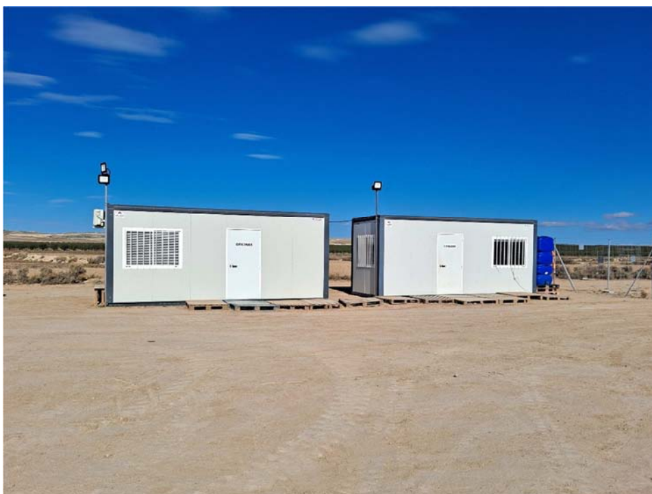
Figura 8.11. Puntos de luz instalados en las casetas prefabricadas, orientados hacia el interior de la parcela y hacia abajo
