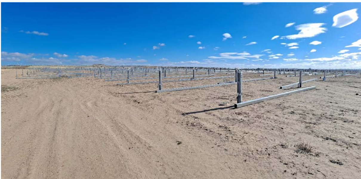
Figura 4.1. Instalación de las estructuras de soporte
