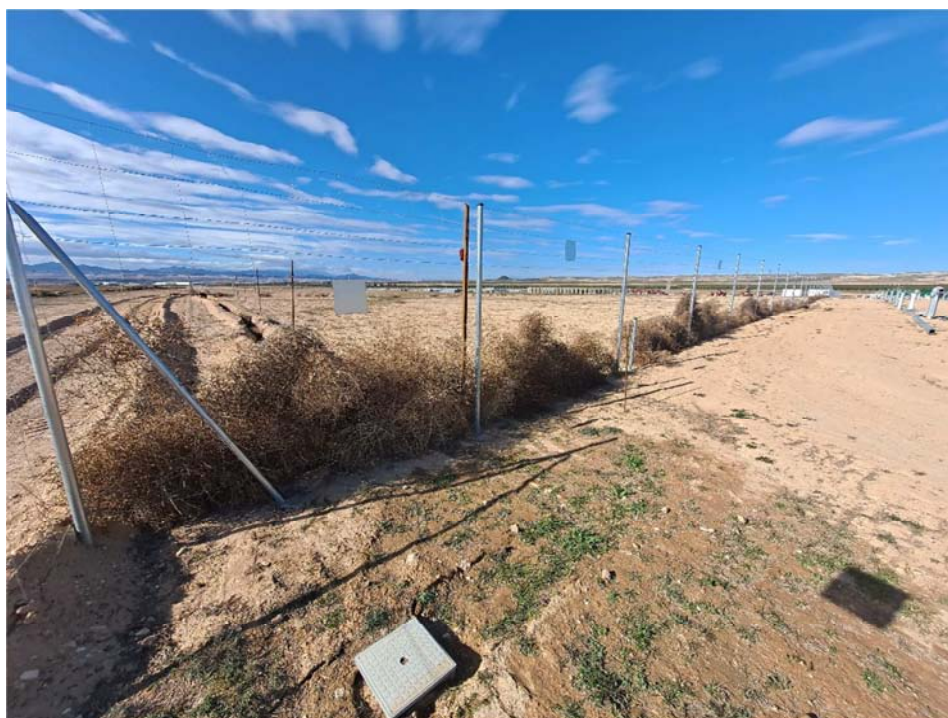
Figura 8.10. Vegetación acumulada en el vallado como consecuencia del viento
