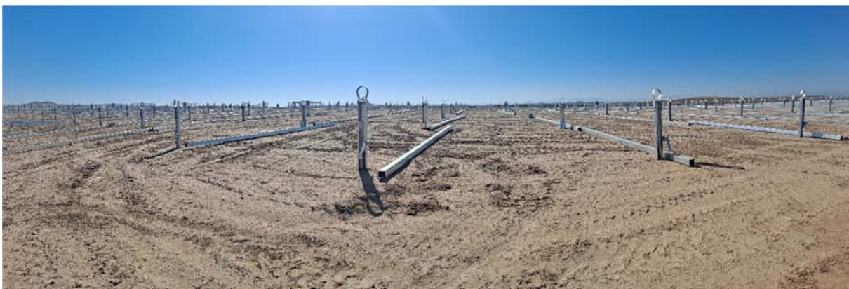
Figura 4.1. Instalación de las estructuras de soporte
