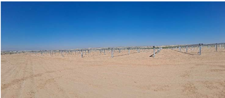
Figura 8.1. Avance en el montaje de las estructuras de soporte
