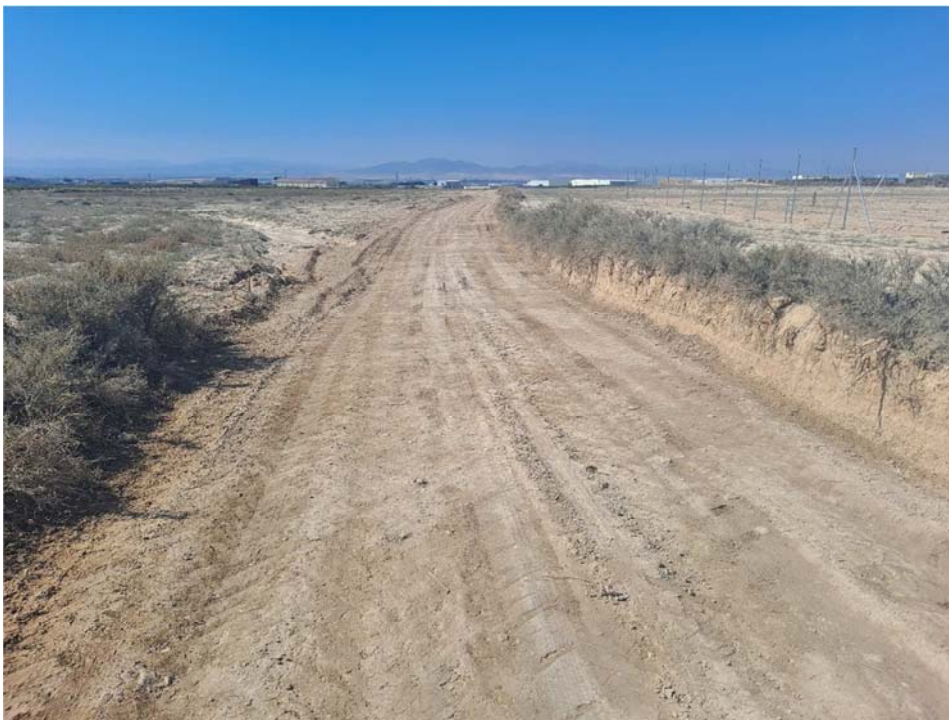
Figura 8.7. Aspecto del camino de acceso donde se observa un tramo acondicionado
