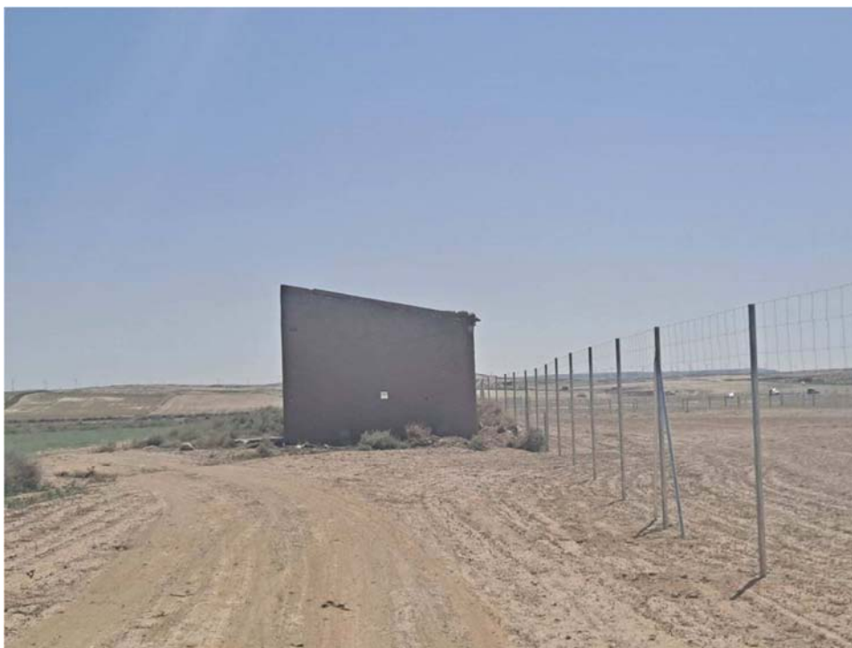
Figura 8.9. Construcción tradicional situada junto a la planta, fuera del recinto vallado y no afectado por las obras
