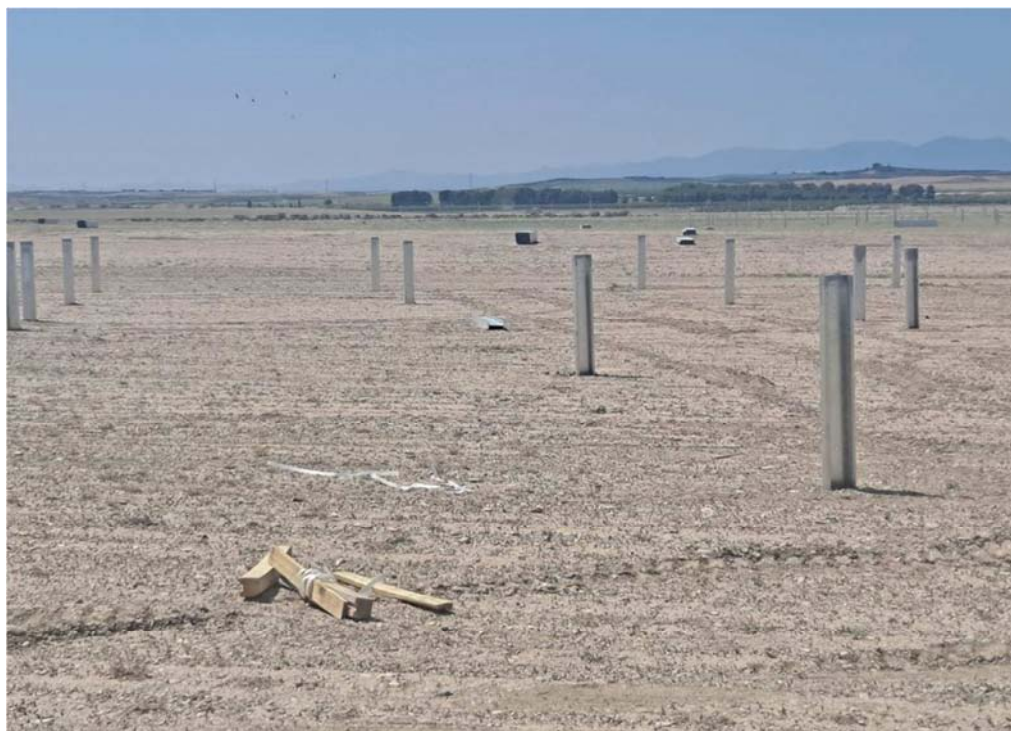
Figura 4.2. Estructuras de soporte ya instaladas
