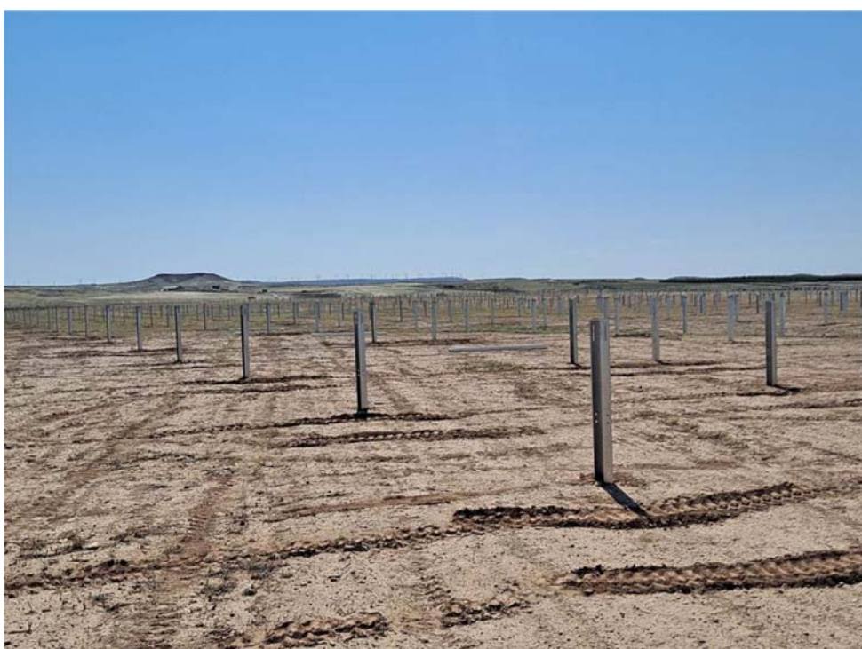
Figura 8.6. Estructuras de soporte ya hincadas
