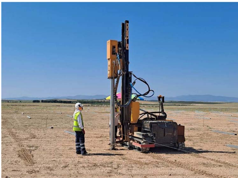
Figura 8.7. Hincado de las estructuras de soporte
