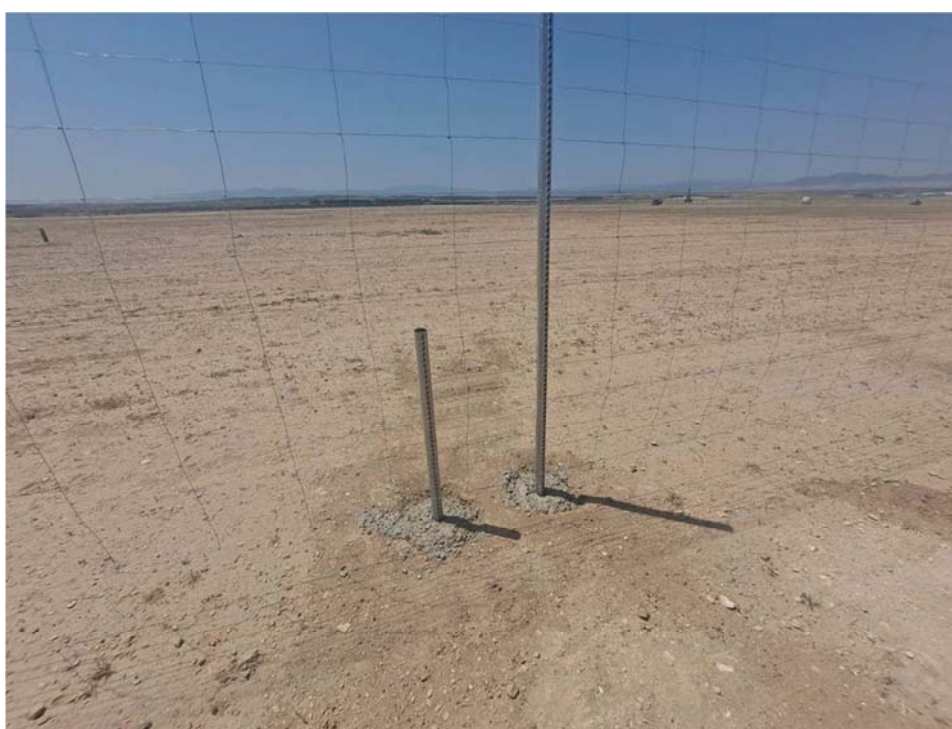
Figura 8.12. Paso para fauna en el vallado, pendiente de terminar
