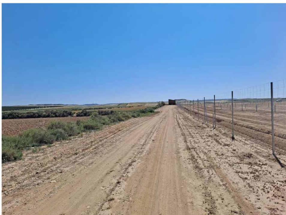
Figura 8.14. Sector de la parcela situada en el perímetro del vallado. Se observa compactación debido al paso de vehículos.
