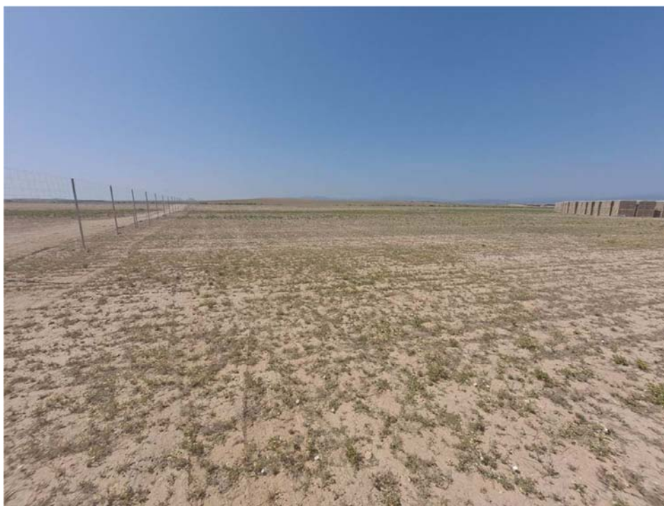
Figura 8.1. Espacio libre de 50 m entre las plantas contiguas "Épila" y "San Pedro"
