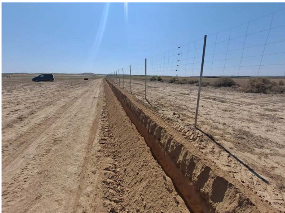
Figura 4.1. Vallado y zanja para el cableado del sistema de seguridad
