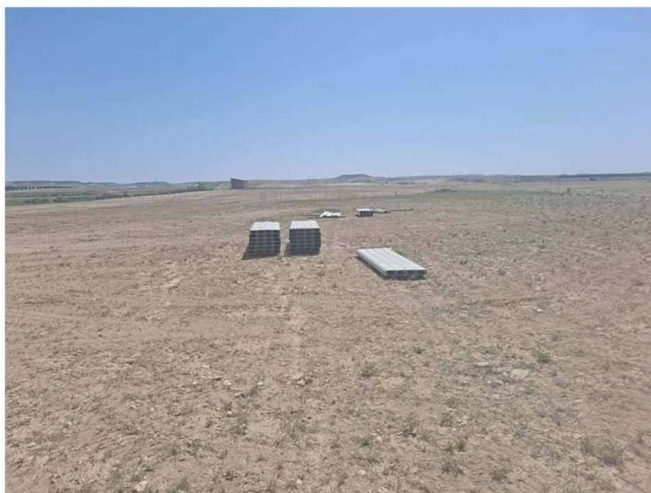
Figura 8.2. Acopio de material para las hincas en la planta
