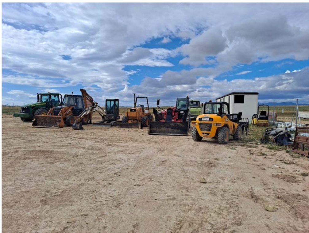
Figura 8.3. Parking de maquinaria y casetas prefabricadas que albergarán los centros de transformación, situados entre las plantas "San Pedro" y "Épila"
