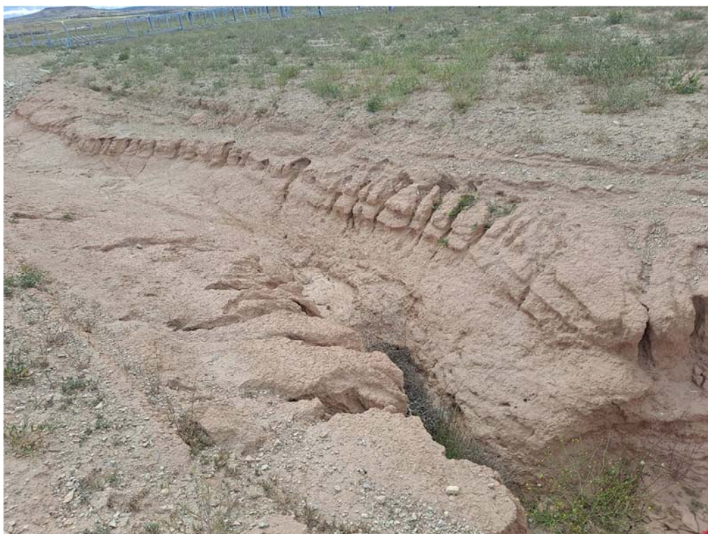
Figura 8.10. Regueros erosivos en los márgenes del cauce del barranco
