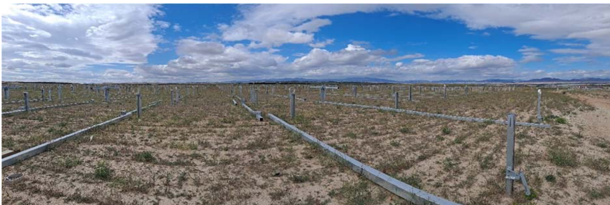
Figura 8.1. Aspecto de la planta a fecha 16-05-24
