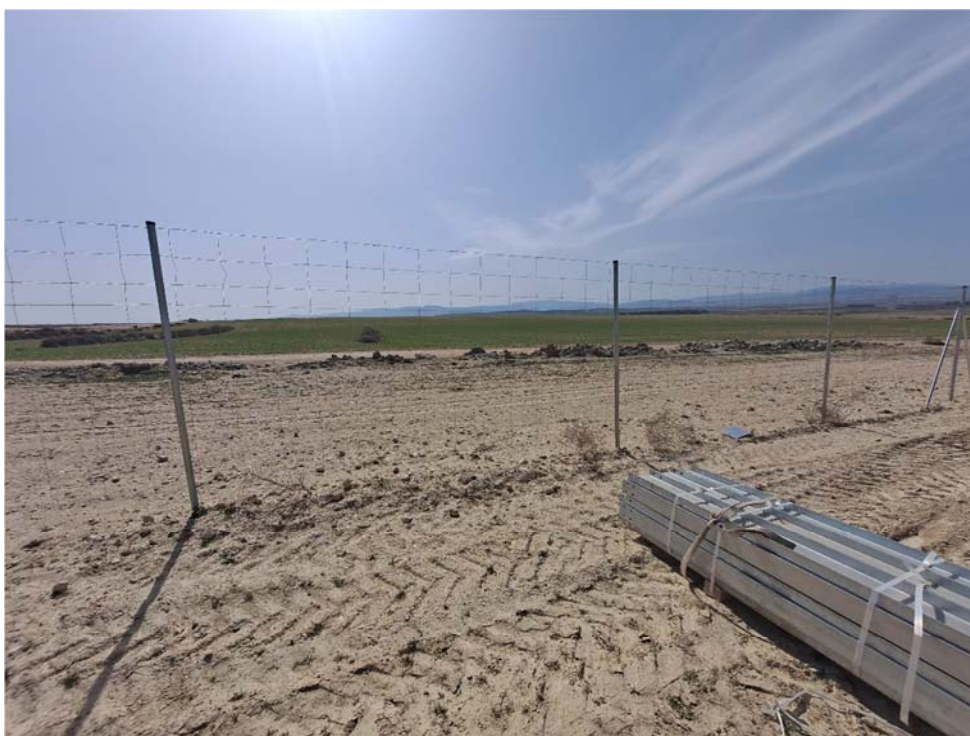
Figura 8.9. Dos vanos consecutivos sin placa de visibilidad en el límite sur del vallado de la planta “Épila 1”
