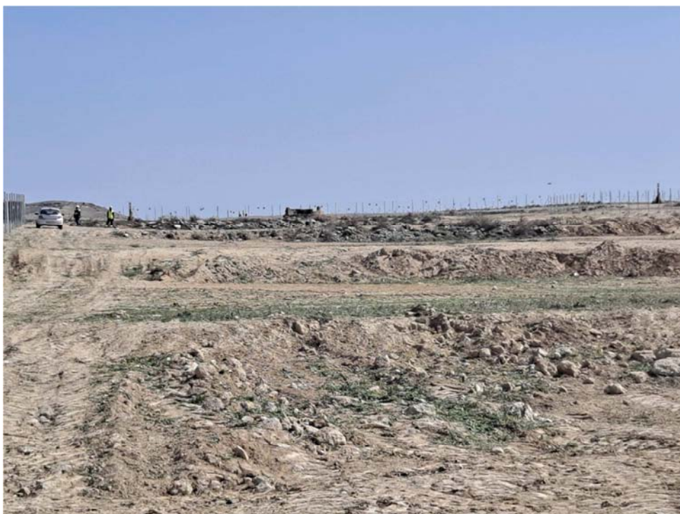
Figura 8.4. Trabajos de replanteo en la planta “Épila 2B”
