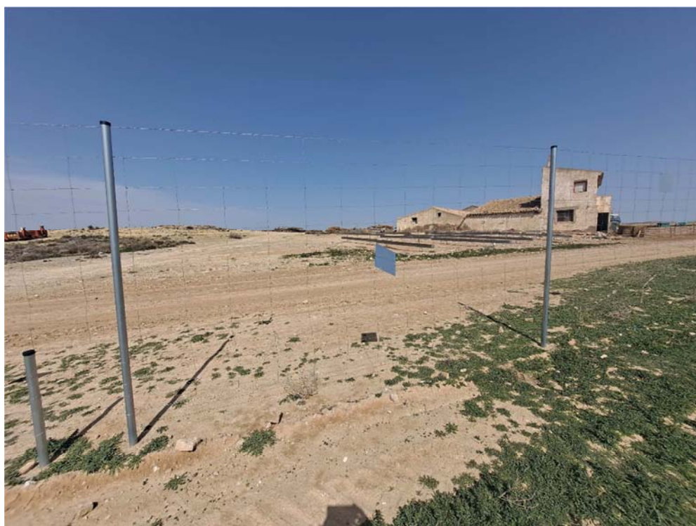
Figura 8.6. Placa de visibilidad con un solo punto de anclaje, en el límite norte del vallado de la planta “Épila 2B”
