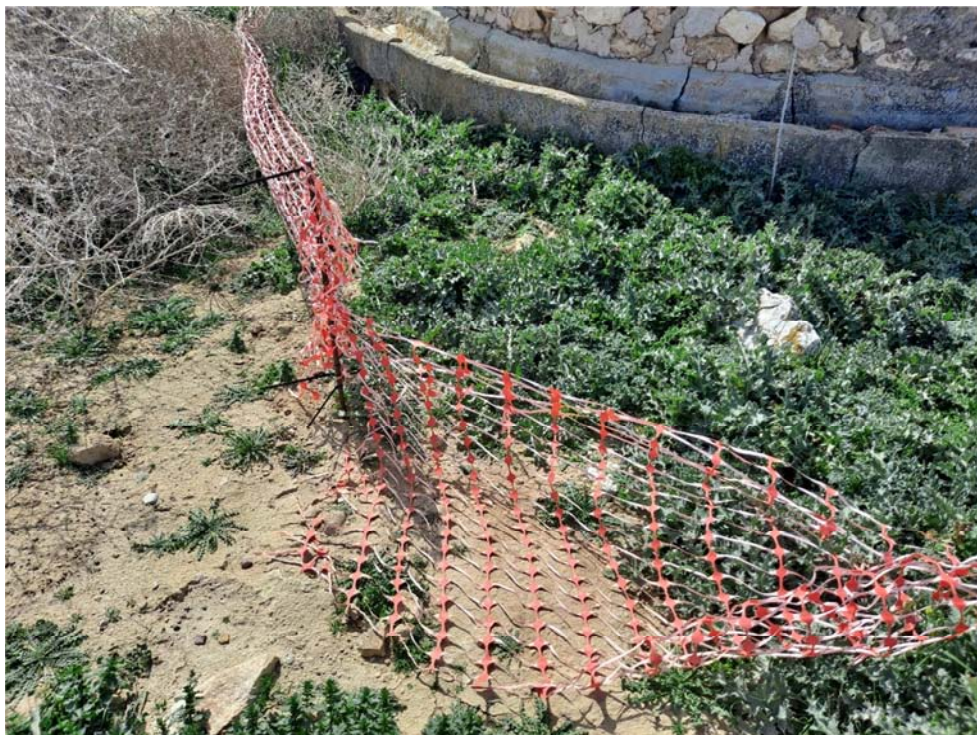
Figura 8.7. Baliza deteriorada que delimita el pozo situado en la planta “Épila 2B”
