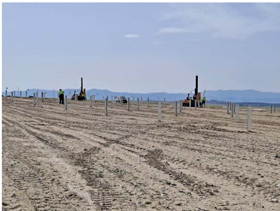
Figura 8.8. Trabajos de hincado de postes en la planta “Épila 1”
