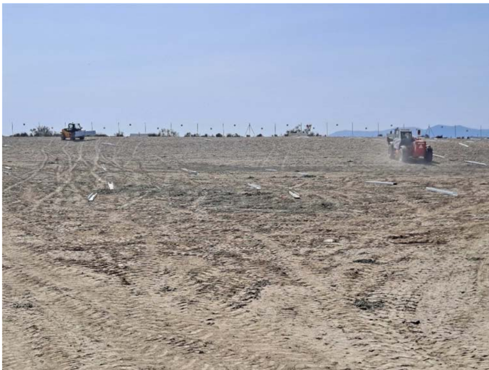
Figura 8.3. Reparto de postes en la planta “Épila 2A”. Se observa la escasa cantidad de polvo que genera la maquinaria al circular
