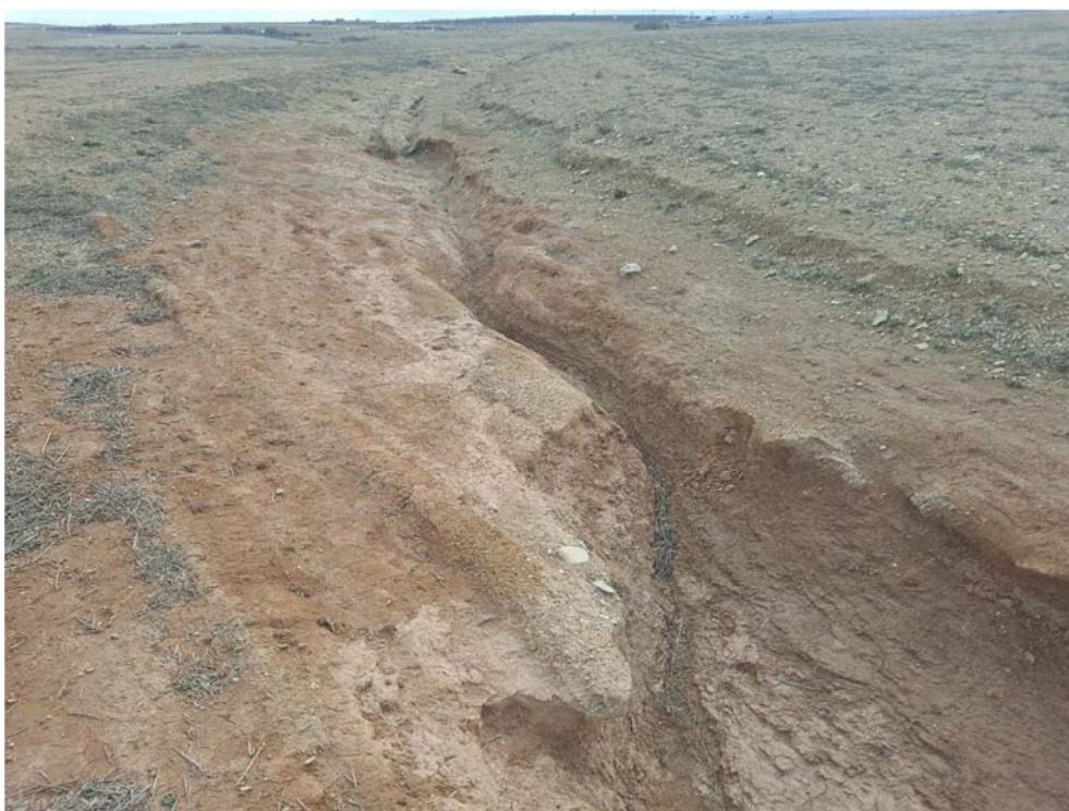
Figura 8.2. Cauce con regueros erosivos que atraviesa la planta “Épila 3”
