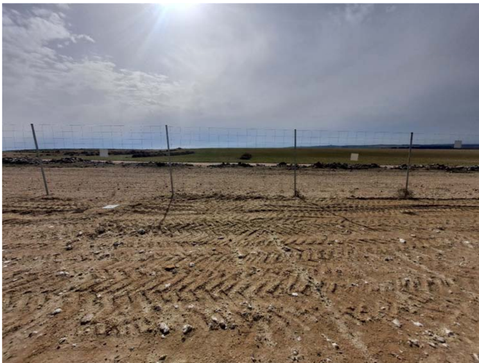
Figura 8.9. Tramo del vallado sin placa de visibilidad en la planta “Épila 1”
