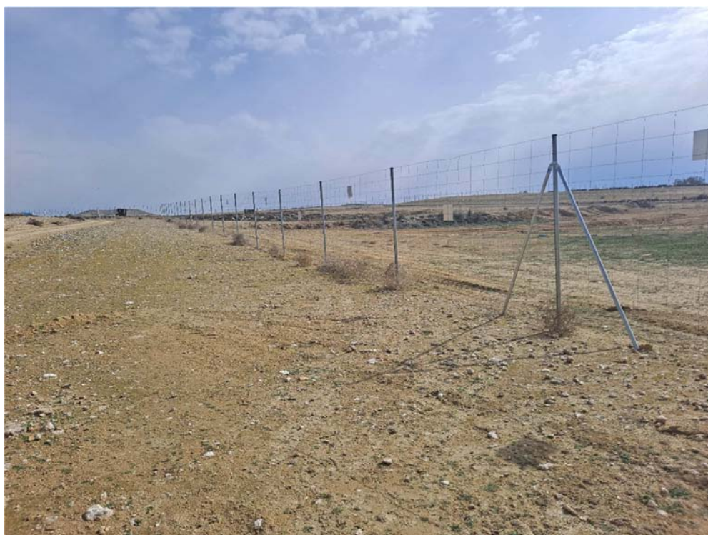
Figura 8.6. Vegetación acumulada en distintos puntos del vallado en la planta “Épila 2B”
