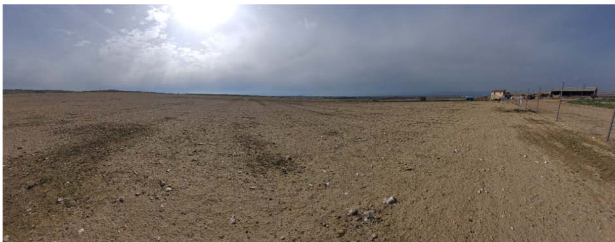
Figura 8.8. Aspecto de la planta “Épila 1” a fecha 15-02-24
