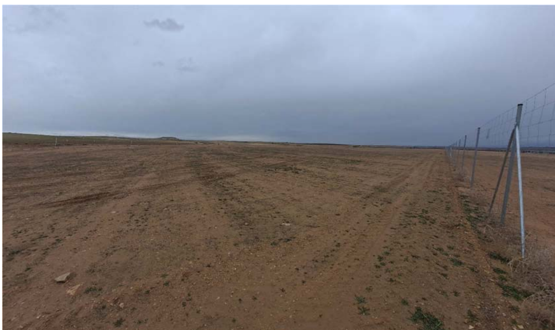
Figura 4.1. Aspecto de la planta “Épila 3” a fecha 15-01-2024
