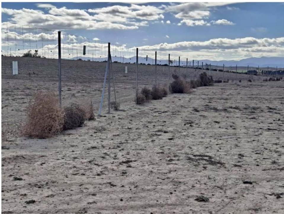
Figura 8.3. Vegetación acumulada en el vallado como consecuencia del viento en la planta “Épila 2A”
