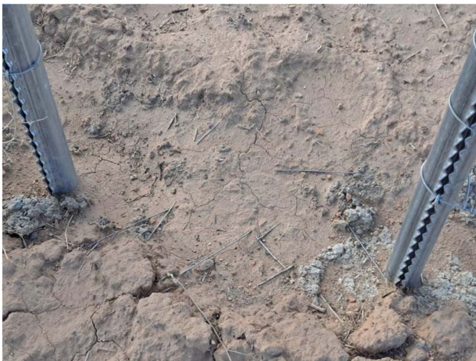
Figura 8.1. Alambres en el suelo en la planta “Épila 3”, observados en los pasos de fauna
