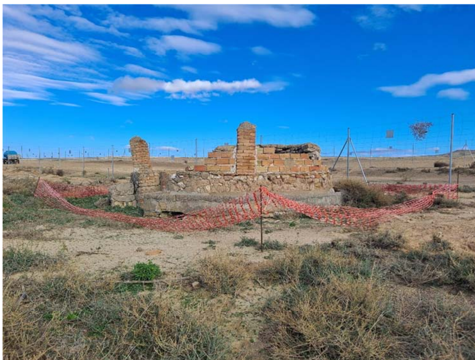
Figura 8.4. Balizado del pozo localizado en la planta “Épila 2B”, en buen estado
