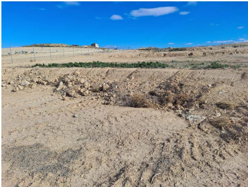
Figura 8.7. Acondicionamiento parcial de los ribazos realizado en la planta “Épila 2B”
