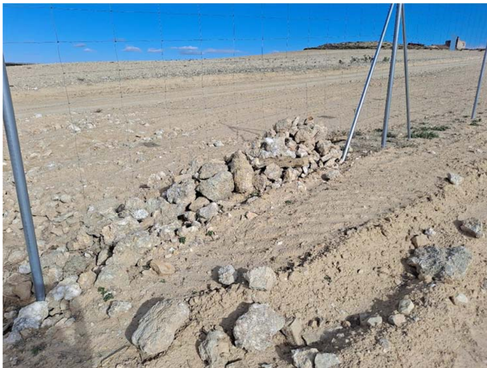
Figura 8.8. Punto de obstrucción del paso inferior del vallado, en el extremo norte del primer ribazo de la planta “Épila 2B”
