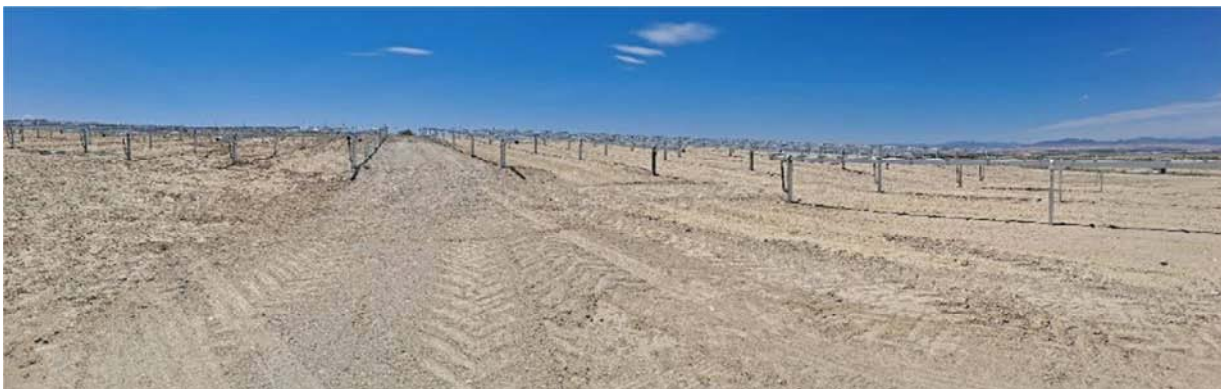
Figura 8.5. Aspecto de la planta “Épila 2A”. Se han hincado todos los postes verticales y colocado los seguidores restantes
