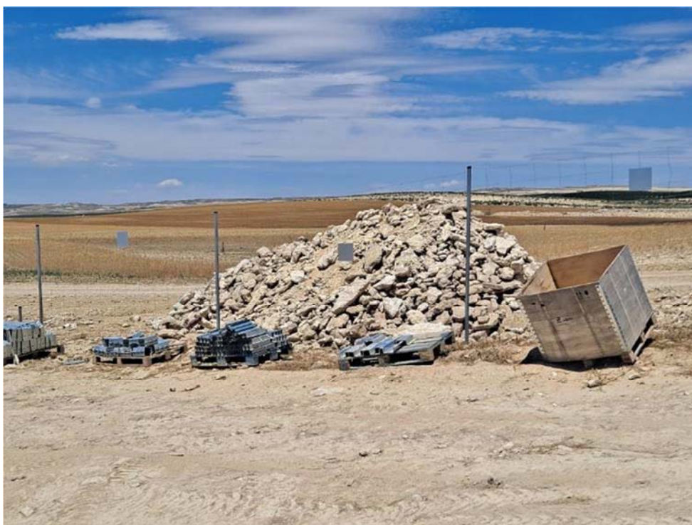
Figura 8.15. Acopio de tierras y rocas, procedente del suavizado de los ribazos en “Épila 2B”, situado por fuera del vallado
