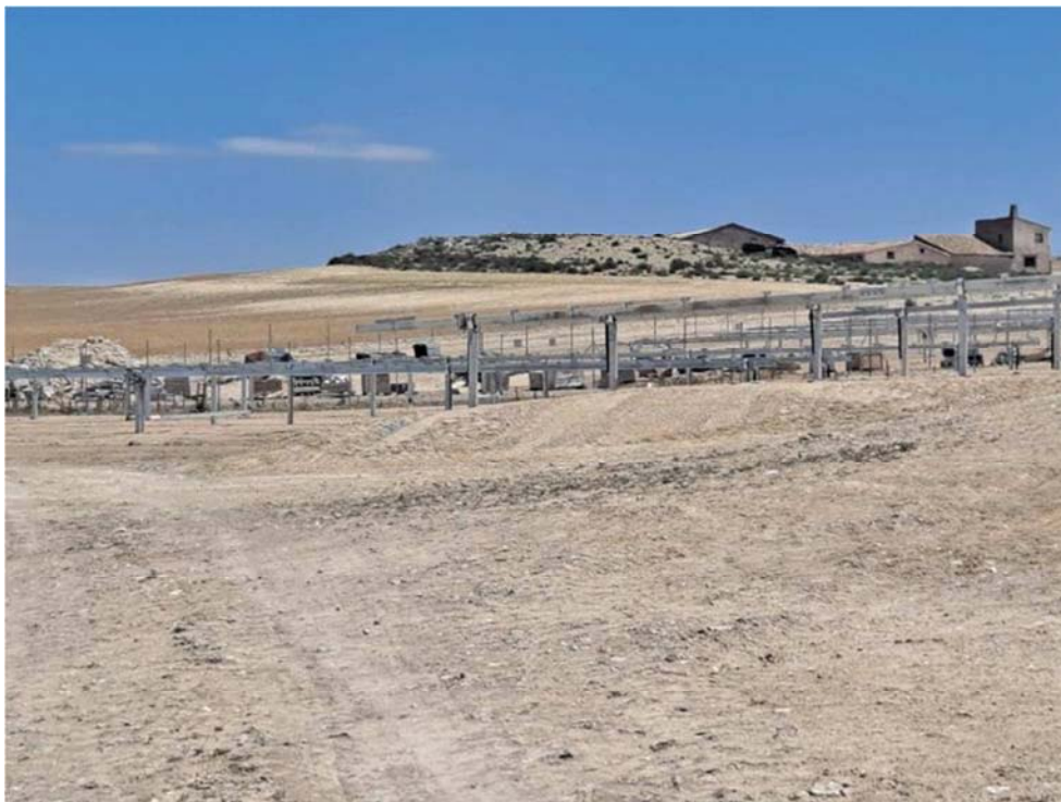
Figura 8.7. Pequeños movimientos de tierra realizados para la nivelación del terreno
