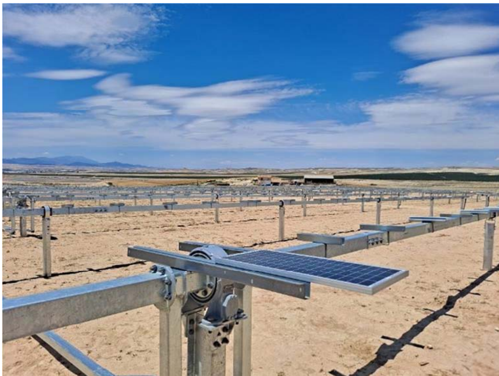
Figura 8.17. Aspecto de la planta “Épila 1”, donde se están colocando placas solares
