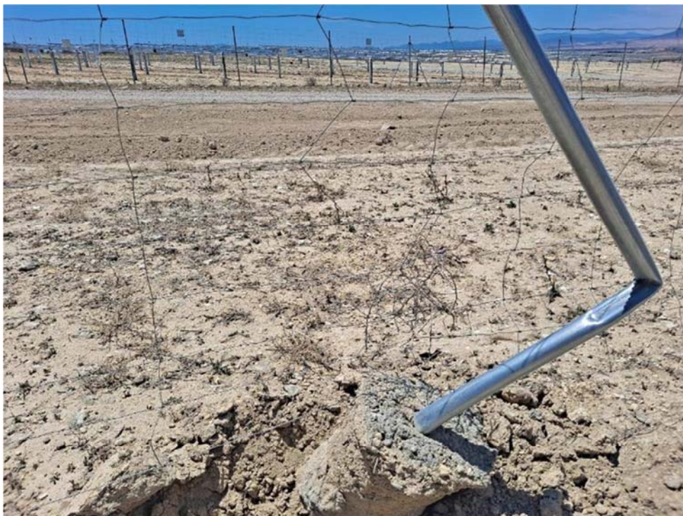
Figura 8.13. Vallado roto al doblarse el poste, dando lugar a elementos punzantes, en la planta “Épila 2B”
