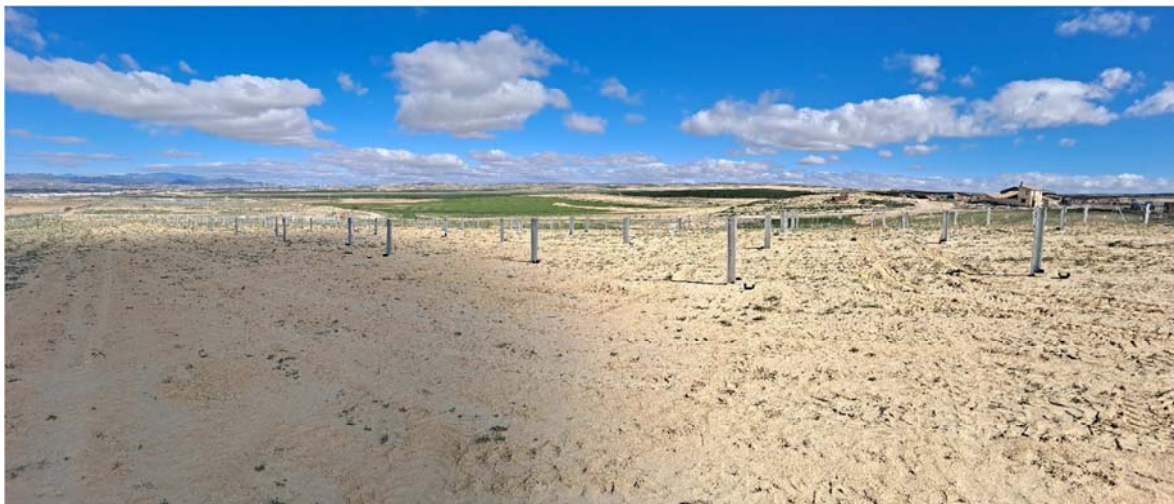
Figura 8.7. Aspecto de la planta “Épila 2A”, con algunos perfiles verticales ya hincados
