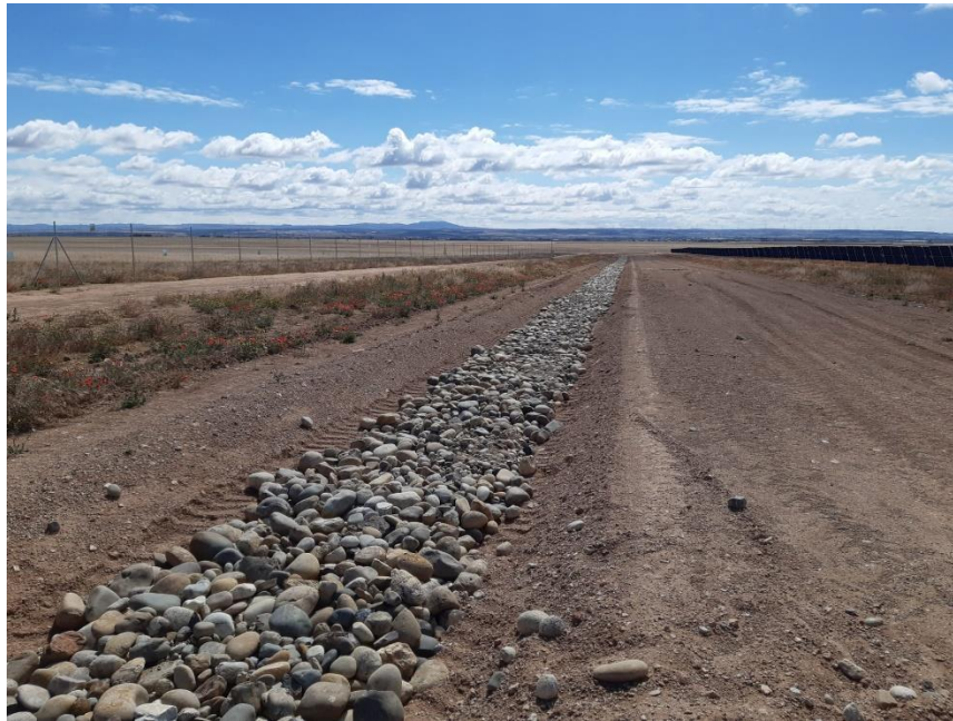
Figura 1. Colocación de gravas en las redes de drenaje.
