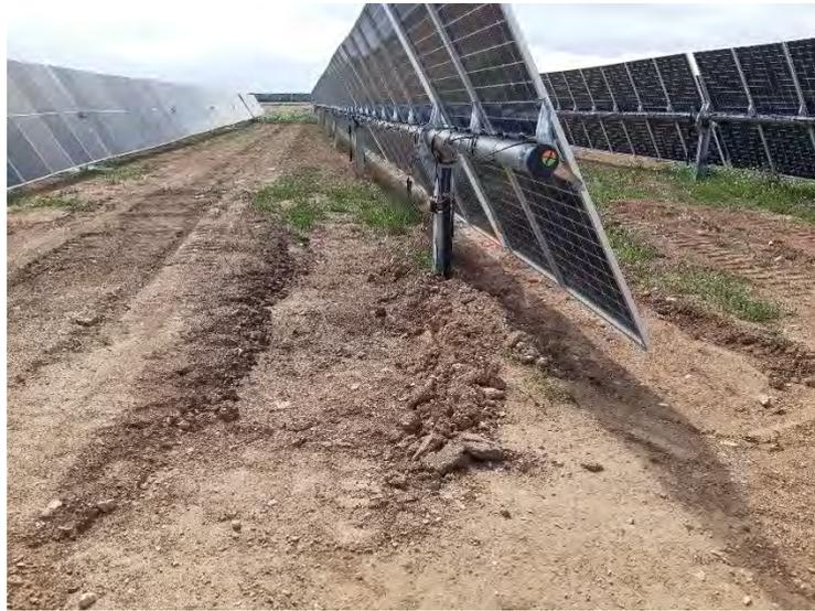
*Figura 1. Desniveles apreciados bajo paneles.*
