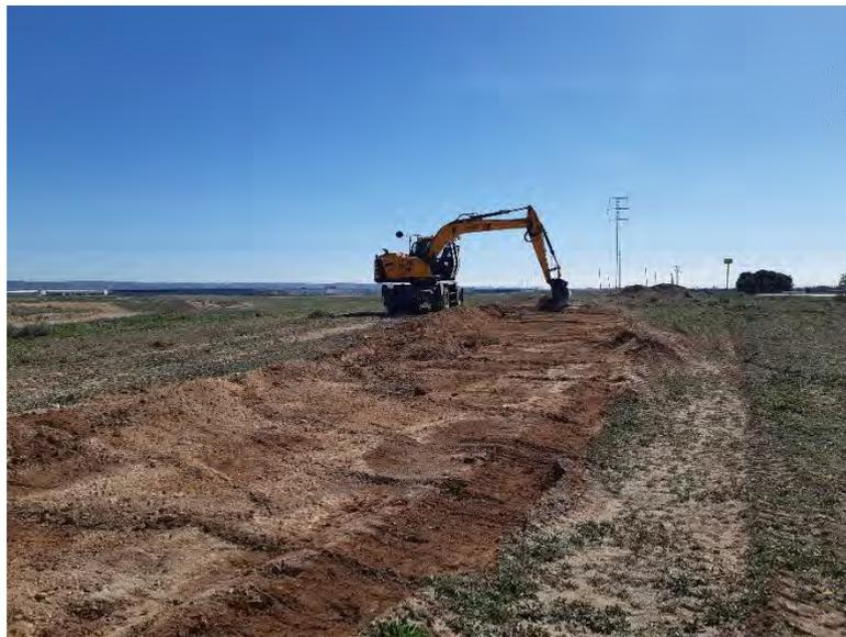
*Figura 1. Extensión de tierra vegetal en el horizonte superior de la zanja de evacuación.*
