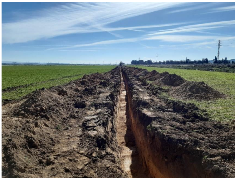
Figura 2. Acopios de tierra vegetal y áridos en el segundo kilómetro de zanja de evacuación ejecutado.
