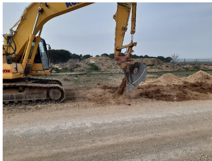
Figura 2. Maquinaria acopiando la tierra vegetal en su caballón correspondiente, cumpliendo con la separación.
