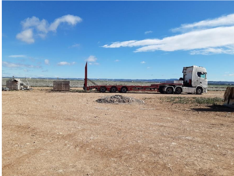
Figura 3. Acopio de residuos de hormigón cerca de la zona de las casetas.
