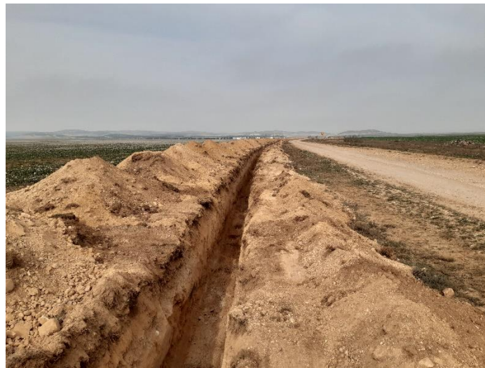
Figura 1. Correcta separación entre tierra vegetal (derecha) y áridos (izquierda).
