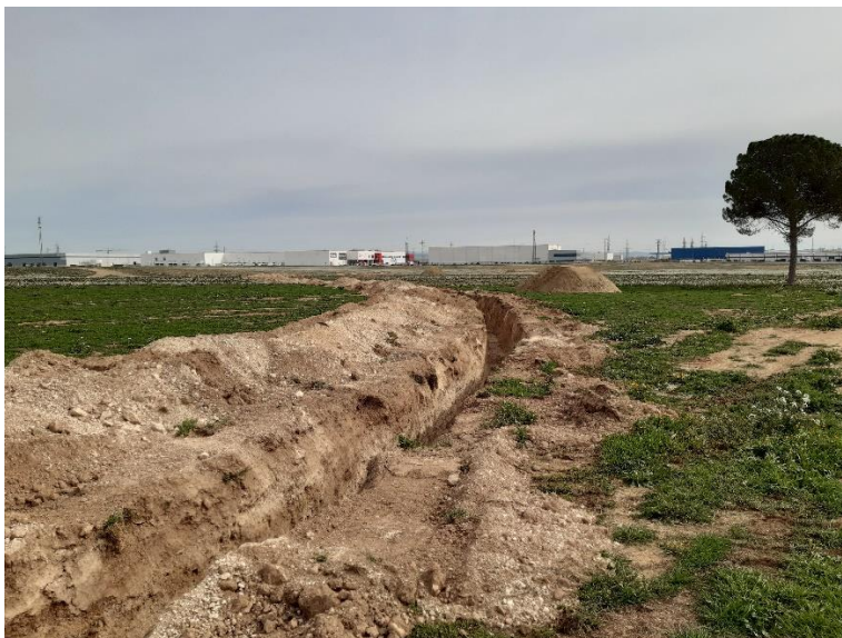
Figura 2. Acopios de áridos y tierra vegetal en los últimos kilómetros de la zanja de evacuación subterránea.
