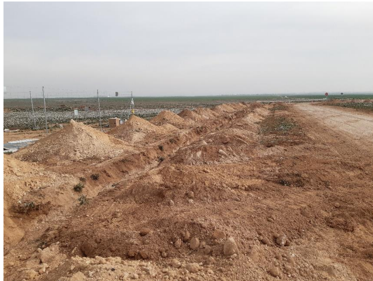
Figura 3. Acopios separados de tierra vegetal y áridos cerca de los Centros de Transformación de la PFV.
