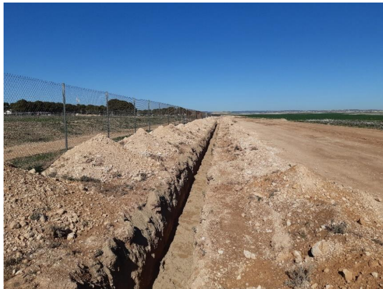
Figura 1. Separación adecuada de tierra vegetal (derecha) con respecto a áridos (izquierda).
