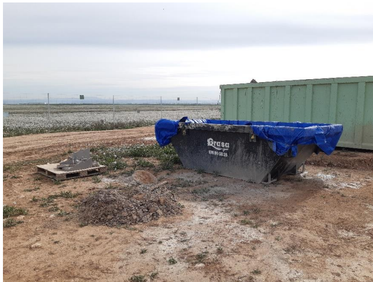
Figura 1. Residuos de hormigón recogidos en el punto limpio de la implantación.
