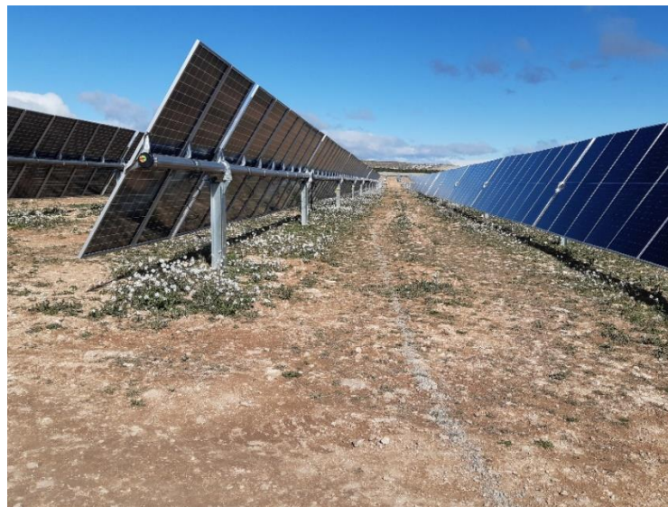
Figura 2. Residuos de hormigón observados en el suroeste de la planta.
