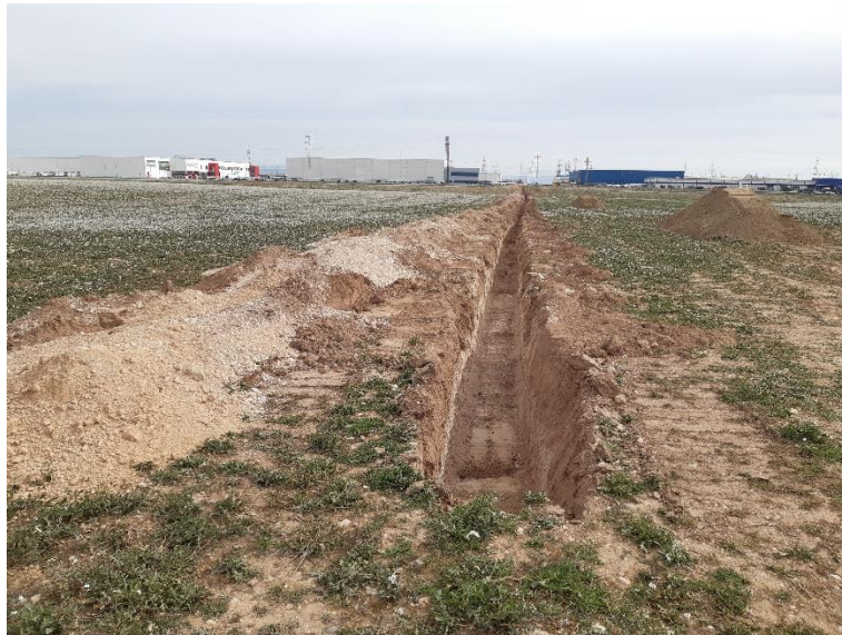
Figura 1. Separación vegetal en el último tramo de la zanja.
