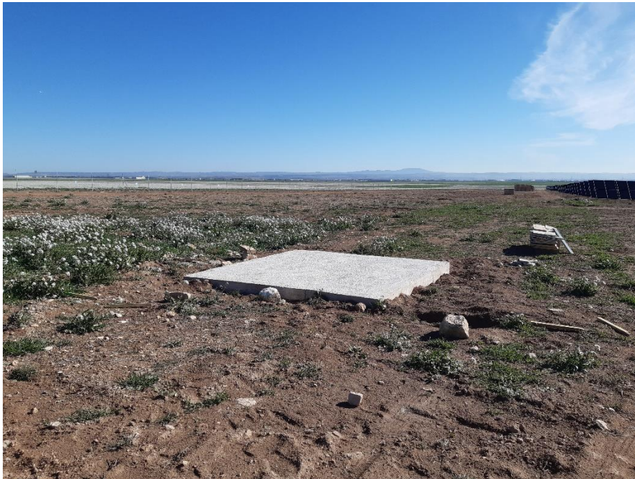
Figura 1. Estructura base de hormigón para el primillar.
