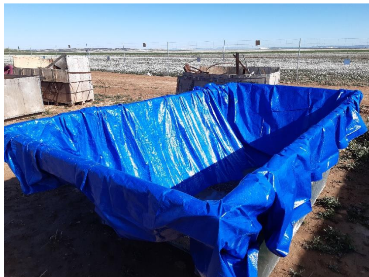
Figura 2. Lona de plástico cubriendo el depósito para evitar derrames.
