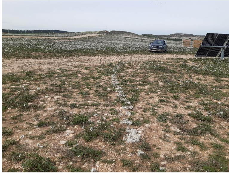
Figura 3. Nuevo reguero de hormigón hallado en la planta fotovoltaica.
