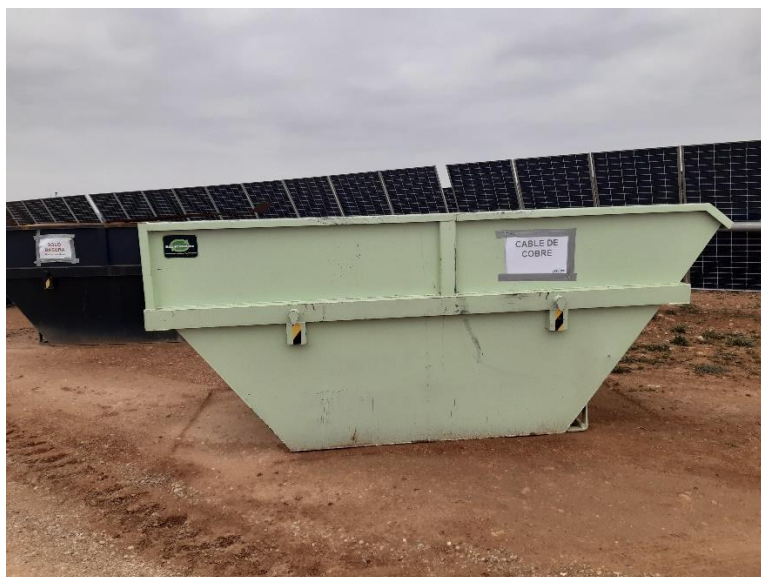
Figura 2. Contenedor de cable de cobre situado en el interior de la implantación sin código LER.
