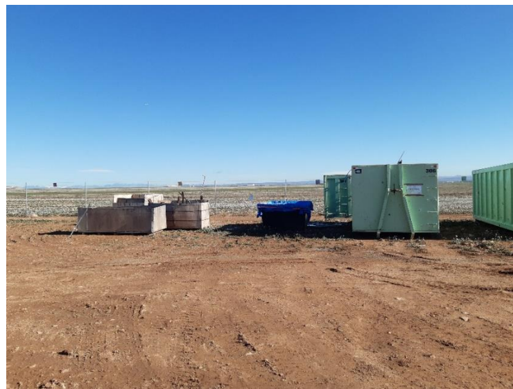
Figura 2. Zona elegida para la limpieza de las hormigoneras.
