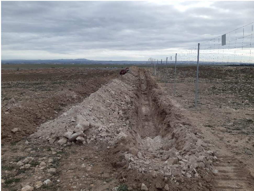
Figura 1. Retirada y acopio de tierra vegetal.
