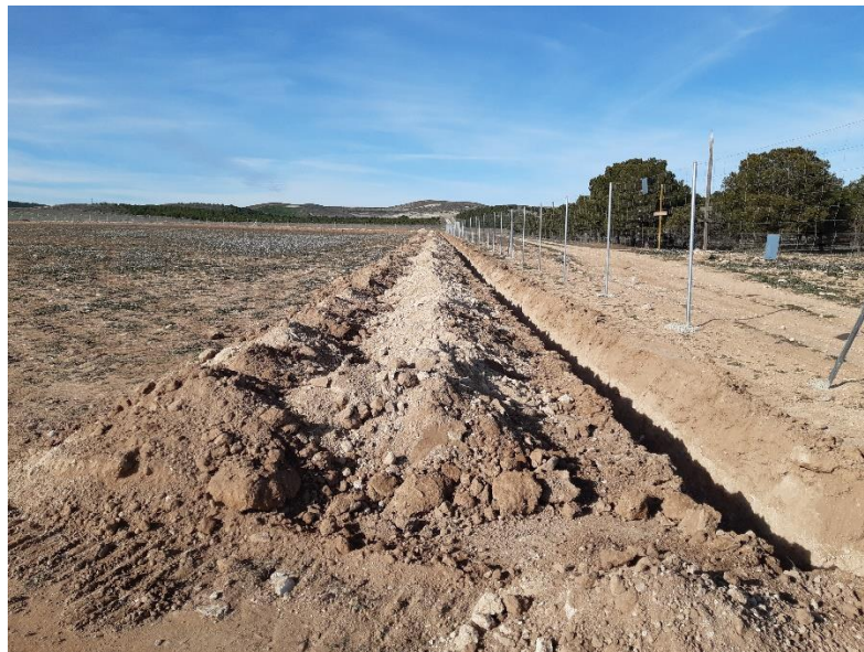
Figura 1. Caballones de tierra vegetal y de áridos divididos correctamente.
