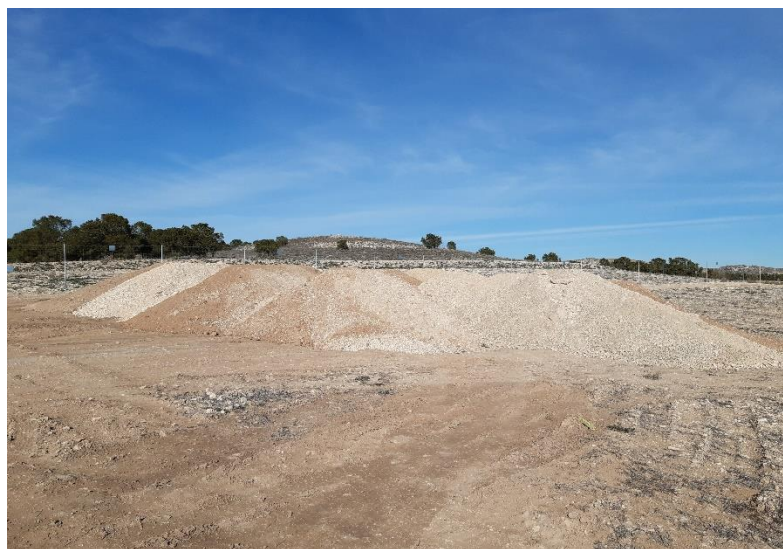
Figura 2. Acopios de tierra vegetal y de áridos procedente de las dos zonas de los inversores.
