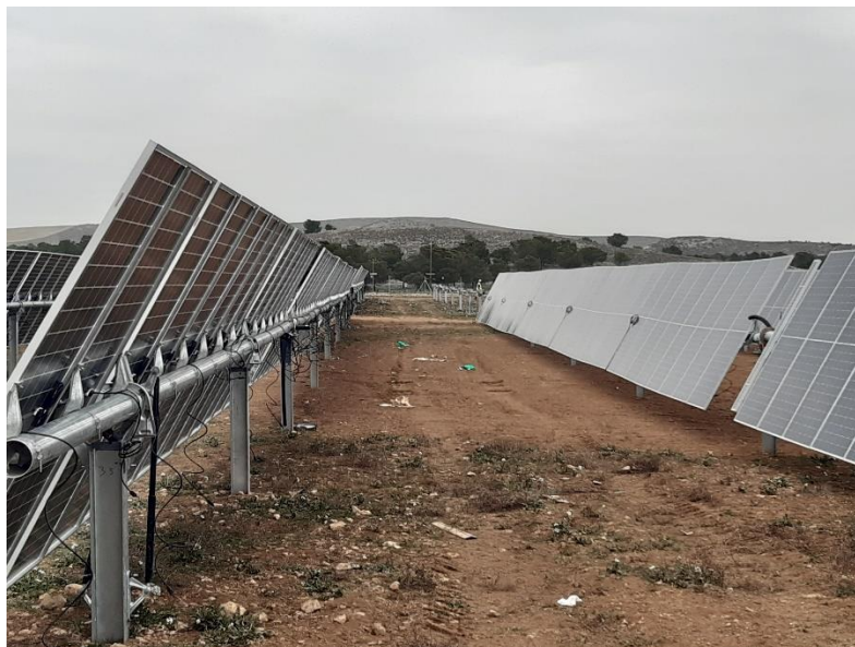
Figura 4. Residuos varios derivados de la instalación de módulos fotovoltaicos.
