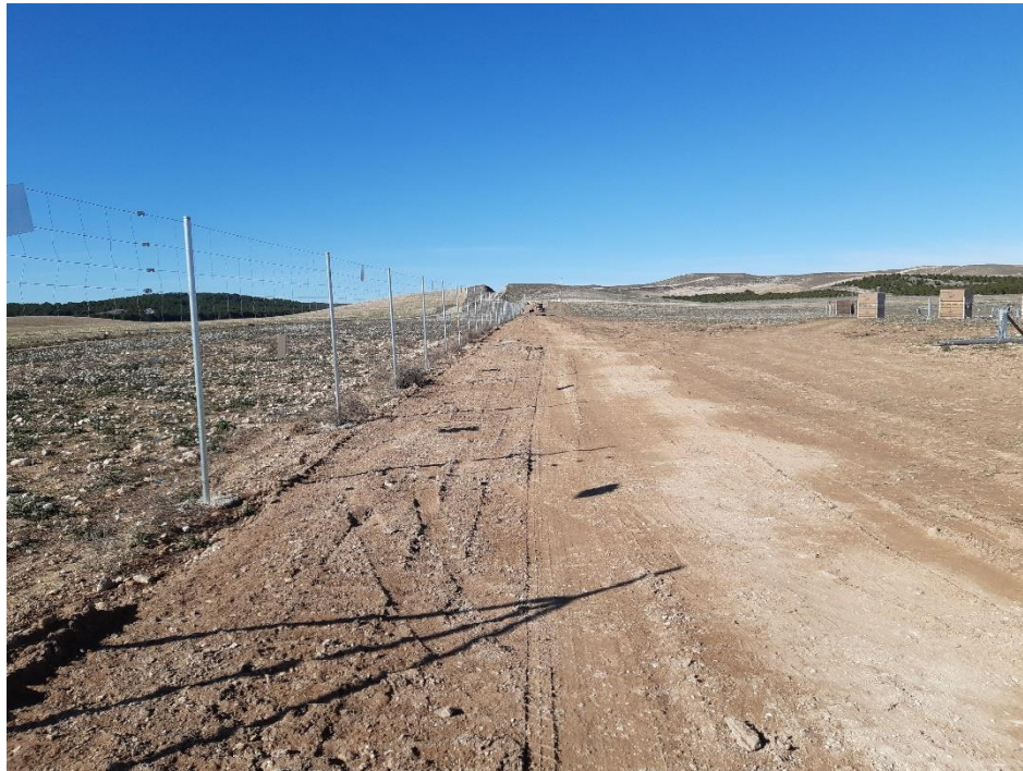
Figura 1. Extensión de tierra vegetal sobre una de las zanjas.
