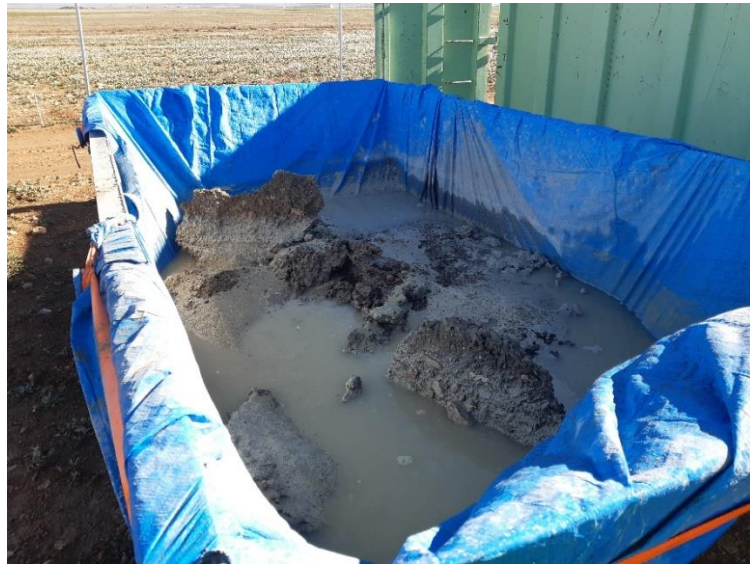
Figura 1. Contenedor de obra destinado para los vertidos de hormigón.
