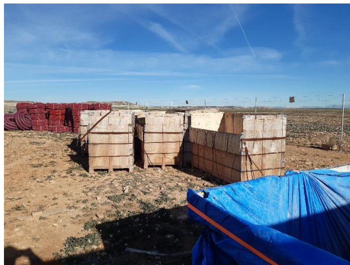
Figura 2. Residuos de madera fuera de su lugar de depósito.
