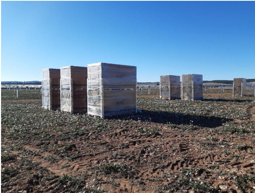
Figura 1. Acopio de módulos dentro del interior de la parcela.
