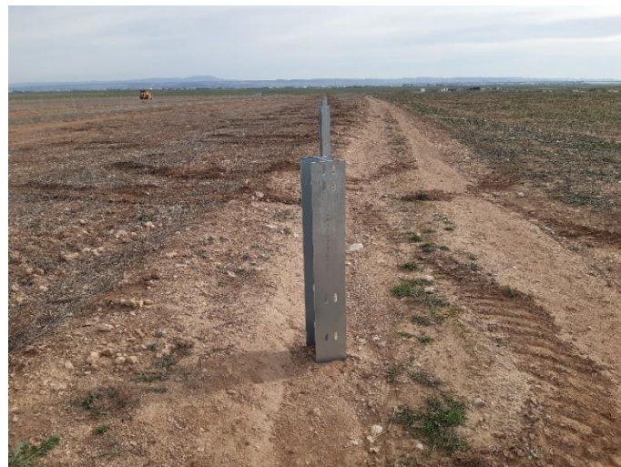
Figura 2. Colocación de hincas.
