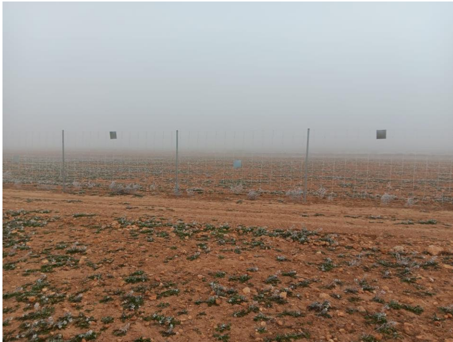
Figura 1. Placas metálicas en el vallado perimetral.
