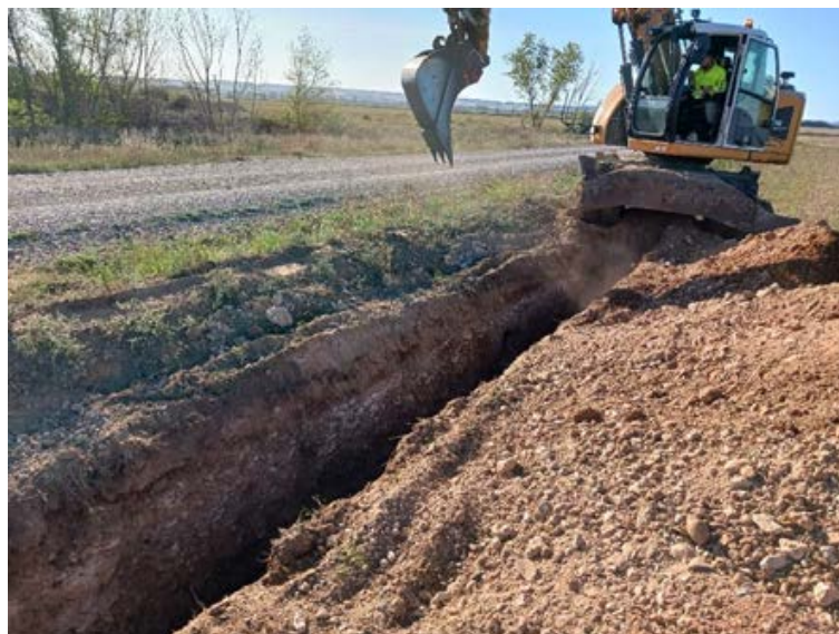
Fig. 2. Supervisión de los trabajos de excavación de la zanja para la línea de evacuación.
