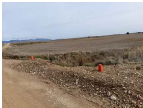
Fig. 1. Instalación de los hitos alrededor de la línea soterrada de evacuación
