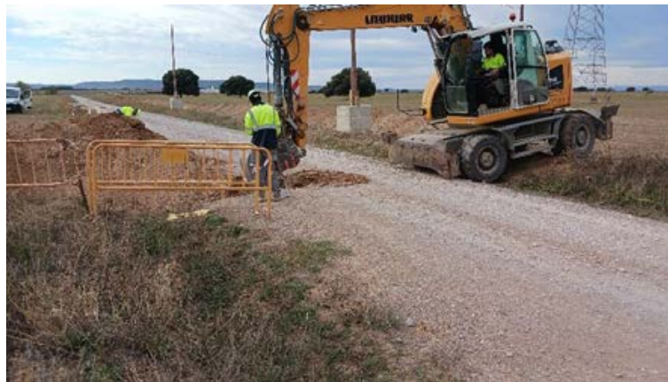
Fig. 1.. Supervisión de los trabajos de excavación de la zanja para la línea de evacuación.
