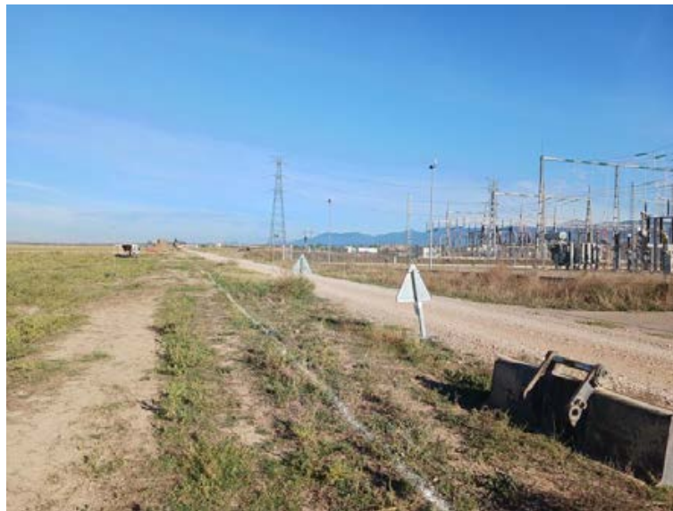
Fig. 1.. Supervisión de los trabajos de excavación de la zanja para la línea de evacuación en entorno de la SET
