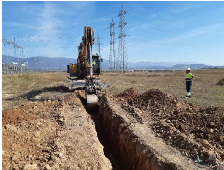
Fig. 1.. Supervisión de los trabajos de excavación de la zanja
