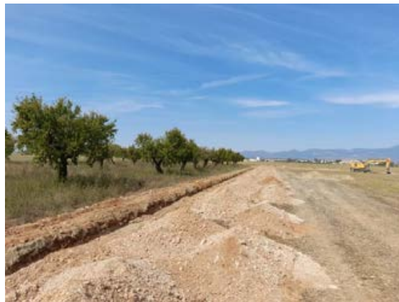
Fig. 1. Apertura de zanjas.
