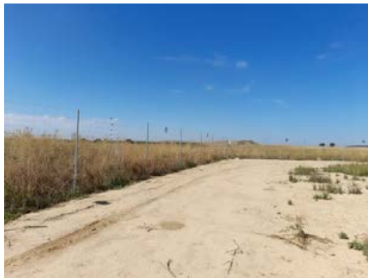
Fig. 1. Colocación de las placas y puesta a punto del vallado.
