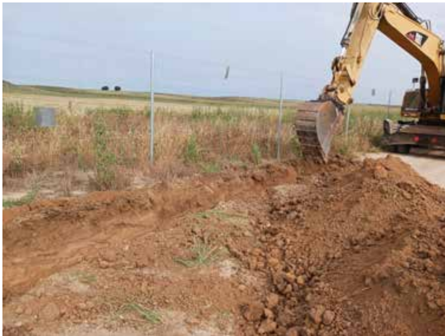
Fig. 1. Control arqueológico en zanja de evacuación eléctrica en parcela E
