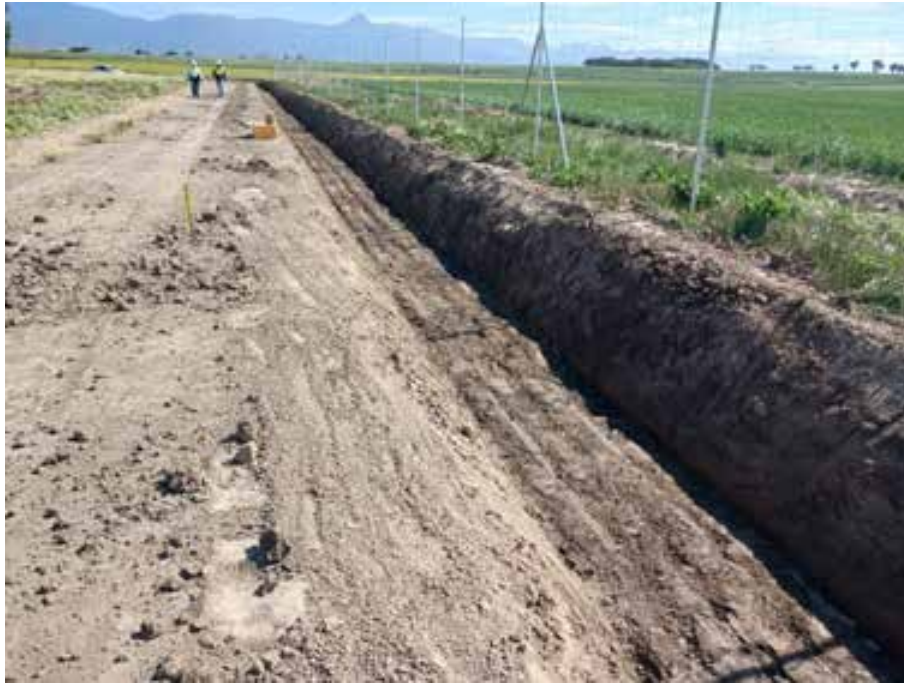
Fig. 1. Zanja del canal lateral de drenaje (tramo 1). Parcela E. Vista general
