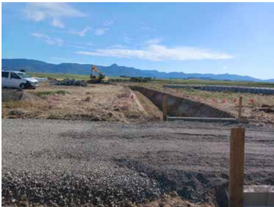
Fig. 2. Zanja del canal principal de drenaje. Parcela E. Vista general desde W.
