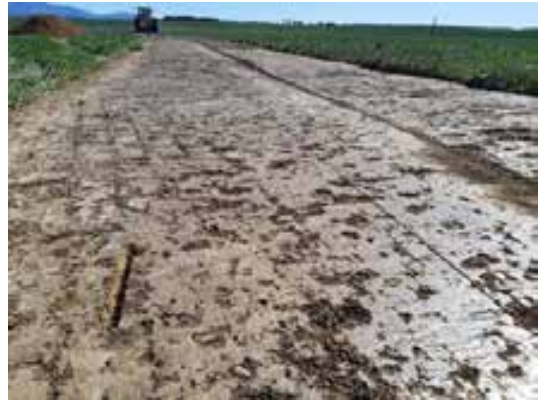
Fig. 6 Desbroce del área de la camp.
