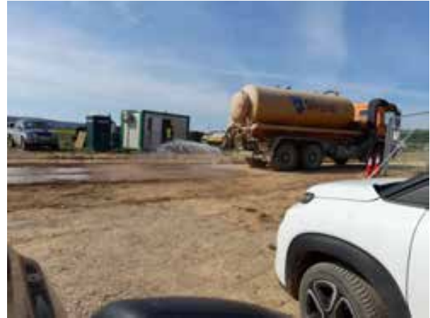
Fig. 1 Zona de acopio de materia y maquina regando para minimizar la formación de polvo y partículas.
