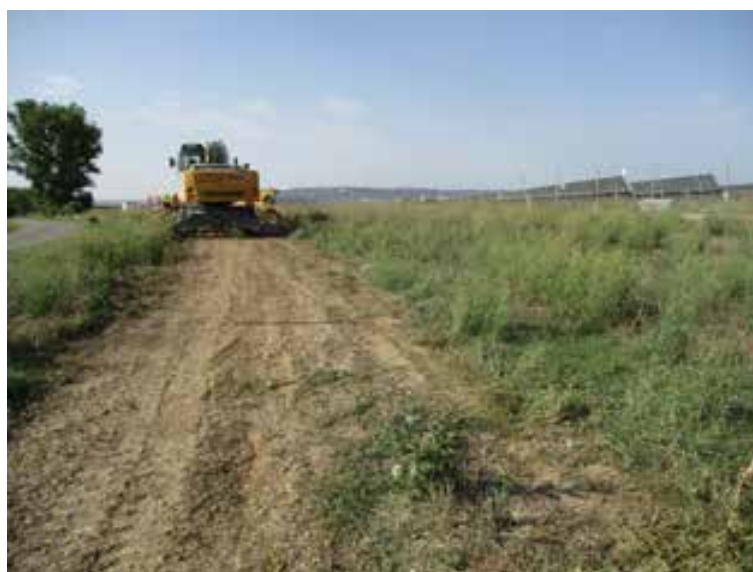
Fig. 2.. Supervisión de los trabajos de excavación de la zanja para la línea de evacuación.
