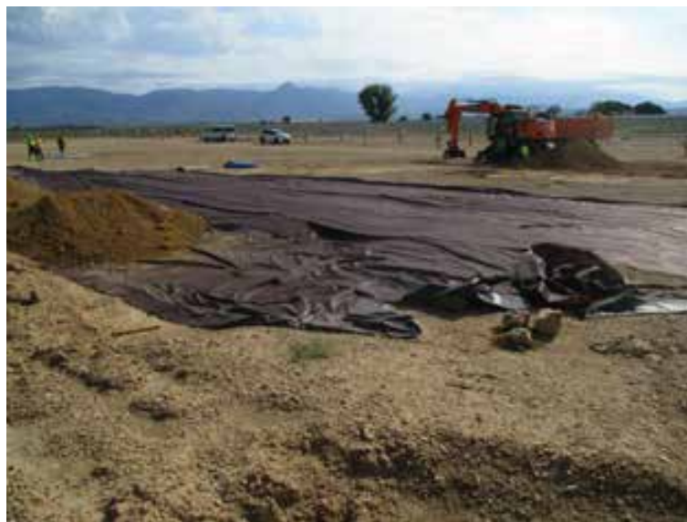
Fig. 1. Supervisión de los trabajos de protección del área de excavación. Instalación de geotextil y capa de tierra de entre 20 y 30cm
