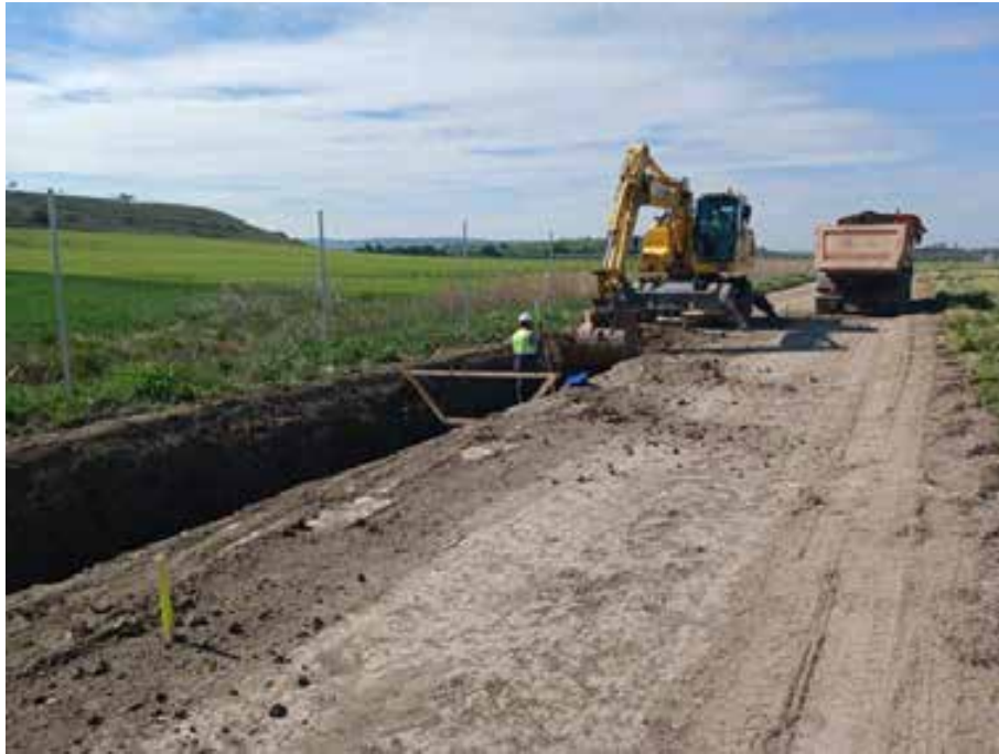
Fig. 1. Zanja de drenaje perimetral de la parcela E. Proceso de excavación.
