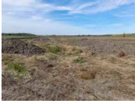
Fig. 3 Acopio de tierras de la red de drenaje.
