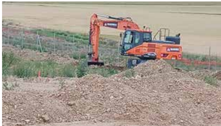
Fig. 1. Apertura de zanja perimetral.
