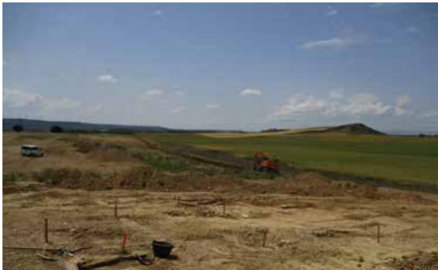
Fig. 2. CyS de la excavación de la zanja al paso por el entorno de la necrópolis
