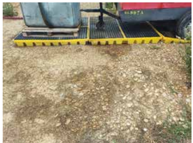
Fig. 2. Detalle de cubeto de retención rebosando por lluvias generando pequeño derrame.
