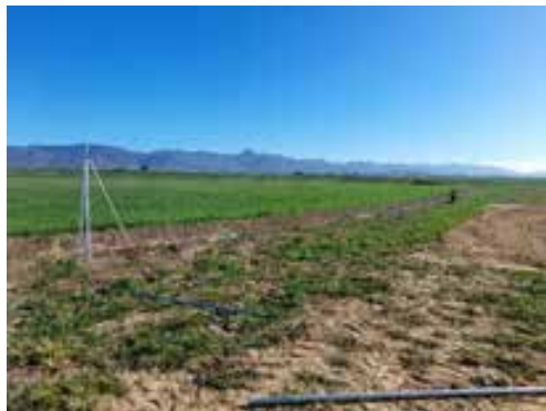
Fig. 3 Estacado y colocación de los postes del vallado perimetral.
