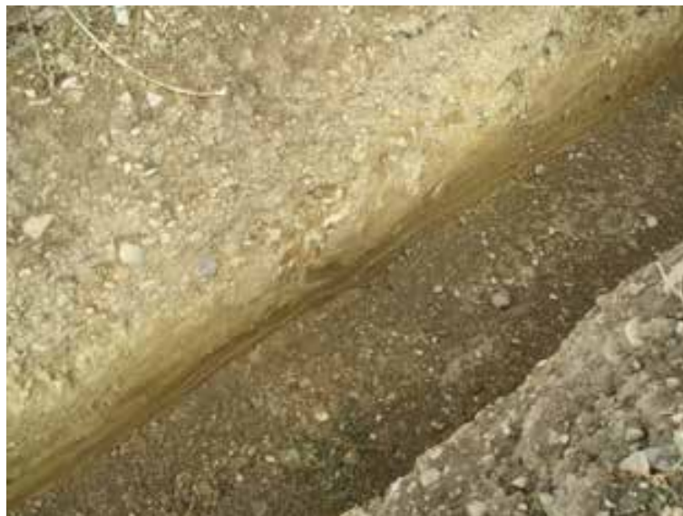
Fig. 4. Supervisión de los trabajos de excavación de la zanja para la línea de evacuación. Detalle de composición estratigráfica del terreno, con las gravas sobre las arcillas
