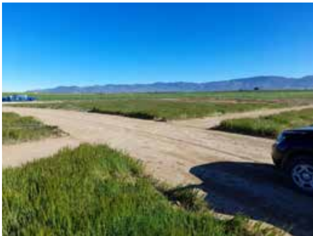
Fig. 2 Apertura y aplanado de los viales interiores respetando las estacas limitantes.
