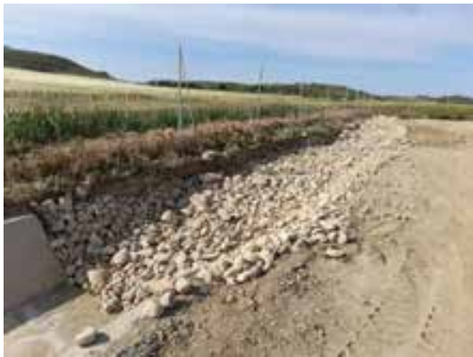
Fig. 1 Colocación de las playas en el final del drenaje hormigonado de la zona sur de la parcela este.
