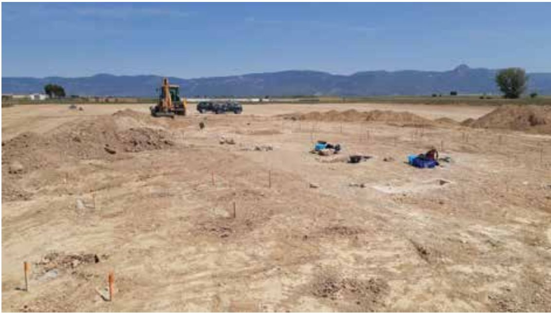
Fig. 1. Limpieza mediante excavadora mixta equipada con cazo de limpieza para la localización de tumbas. Cada estaca marca la posición de una tumba.
