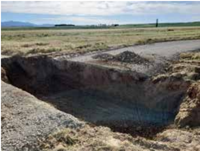
Fig. 1 Apertura de la zanja para la colocación del arco de hormigón que cruza el vial con el canal de drenaje de agua.
