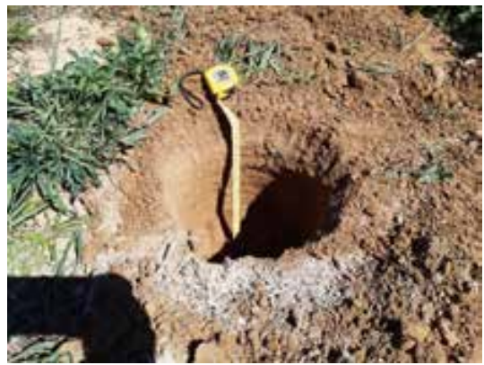
Fig. 2 Instalación del vallado perimetral. Hoyo.
