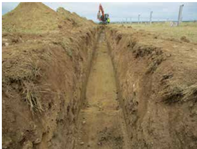
Fig. 2. Zanja de evacuación eléctrica en parcela W
