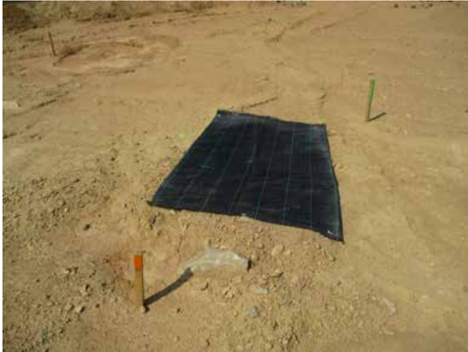
Fig. 3. Adecuación final de yacimiento previo a su futura protección por medio de geotextil y tierra
