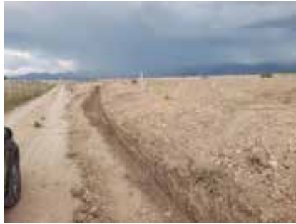
Fig. 1. Apertura de las zanjas para el cableado.
