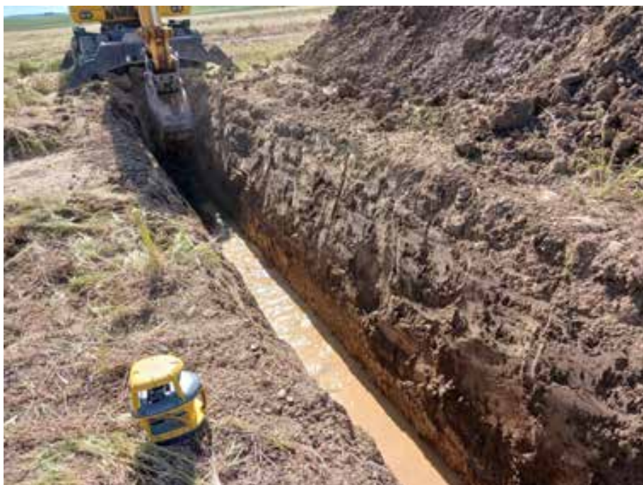
Fig. 2. Zanja del canal lateral de drenaje (tramo 1). Parcela E. Proceso de excavación alcanzando el nivel freático (-1,80 bajo superficie y detalle de perfil estratigráfico.
