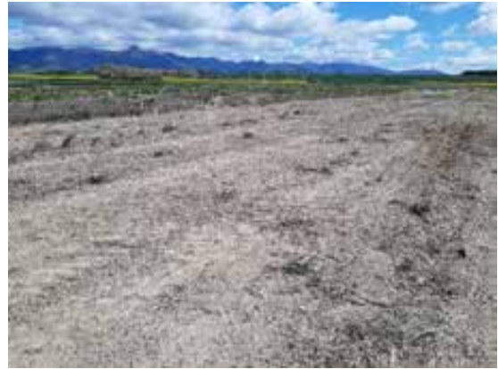
Fig. 2. Desmontes y nivelaciones en parcela E
