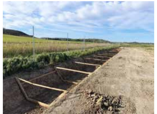
Fig. 2 Apertura de la zanja de la red de drenaje.
