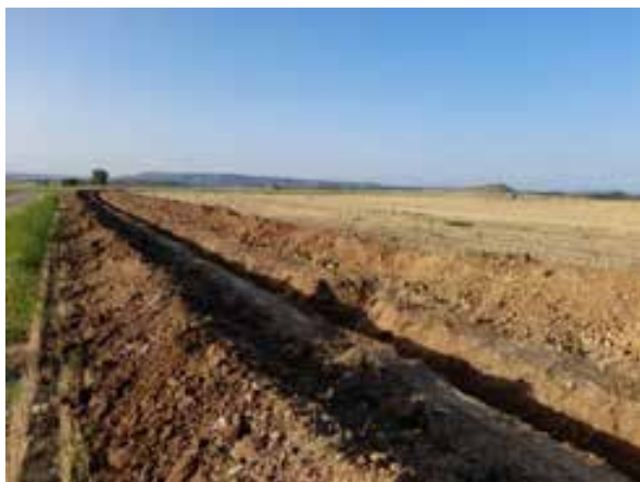
Fig. 2. Apertura de la zanja de media tensión y separación de la tierra vegetal.
