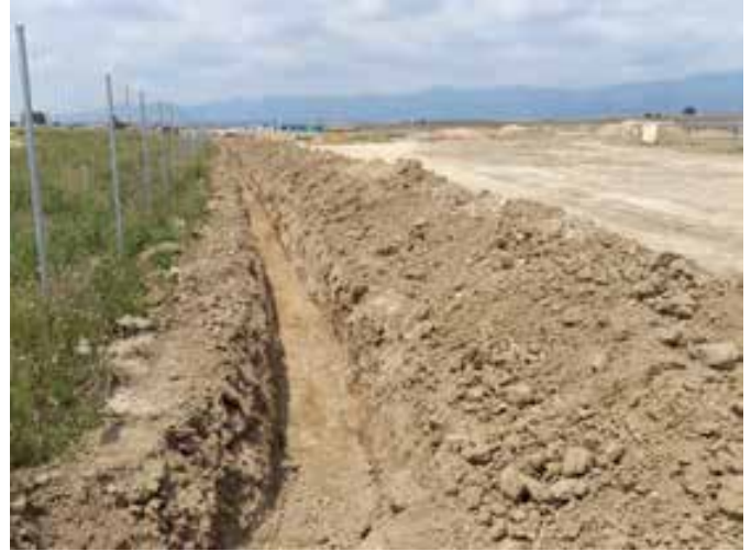
Fig. 1. Apertura de zanjas para los cables en ambas parcelas.
