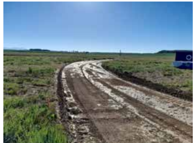
Fig. 2 Apertura y aplanado de los viales interiores respetando las estacas limitantes.
