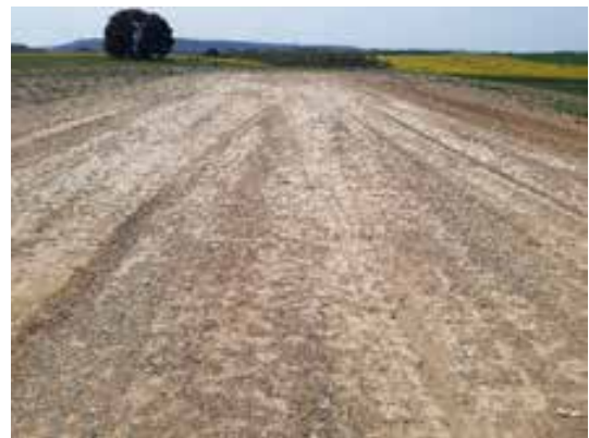
Fig. 4. Nivelaciones en la parcela W sector sur
