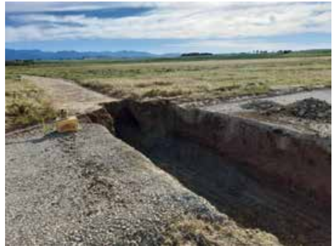
Fig. 1 Apertura de la zanja para la colocación del arco de hormigón que cruza el vial con el canal de drenaje de agua.
