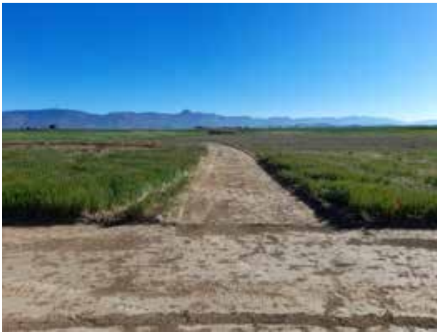
Fig. 1 Apertura y aplanado de los viales interiores respetando las estacas limitantes.
