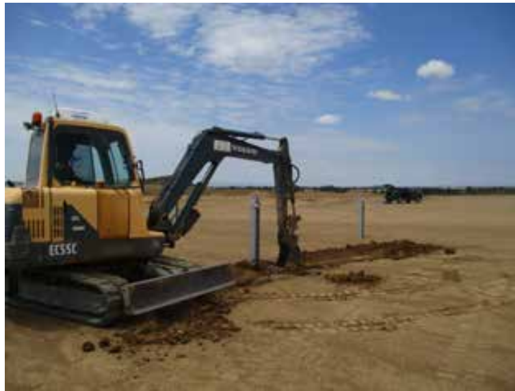
Fig. 1. Excavación para instalación de hincas.
