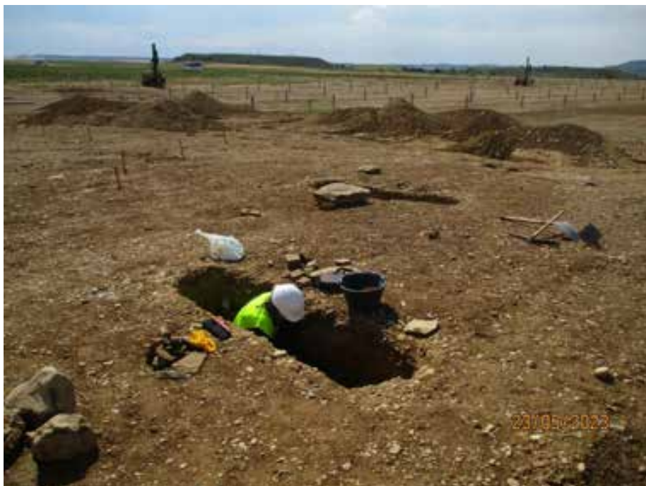
Fig. 3. Tumbas en proceso de excavación.
