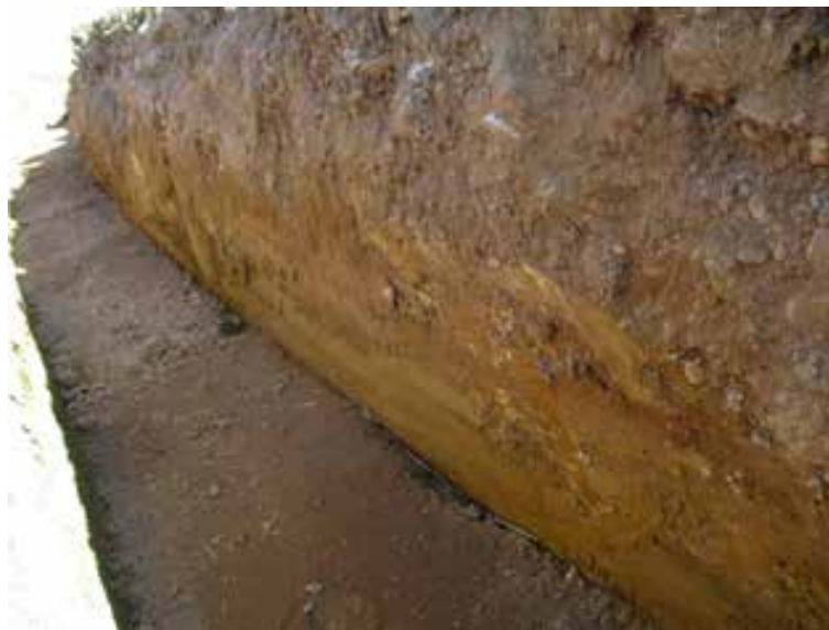
Fig. 4. Zanja de evacuación. Detalle de composición estratigráfica del terreno. Arcillas bajo el estrato superficial.
