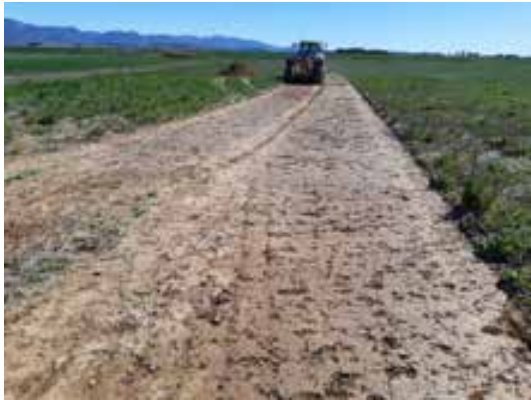
Fig. 5 Desbroce del área de la camp.
