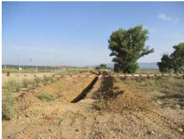
Fig. 3. Supervisión de los trabajos de excavación de la zanja para la línea de evacuación. Extremo S del tramo.
