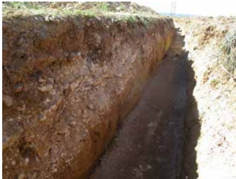
Fig. 3. Zanja de evacuación. Detalle de composición estratigráfica del terreno. Desde la superficie: Terreno vegetal, gravas y arcillas.
