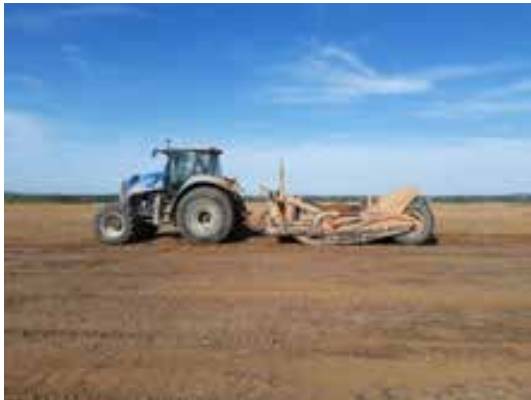
Fig. 3 Desbroce y nivelación de las parcelas.
