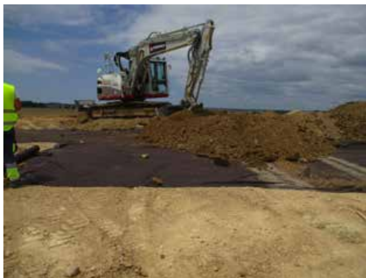
Fig. 2. Supervisión de los trabajos de protección del área de excavación. Instalación de geotextil y capa de tierra de entre 20 y 30cm
