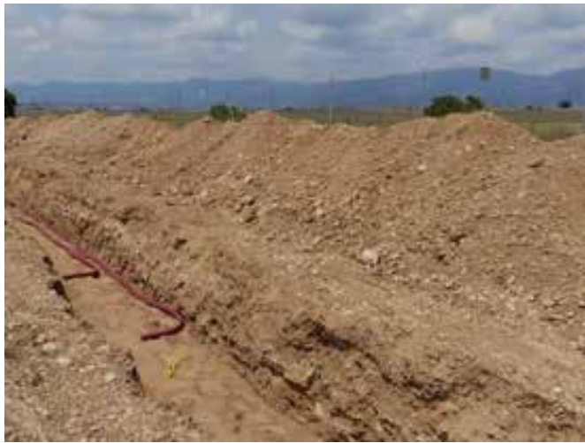
Fig. 1. Apertura de zanjas para los cables en ambas parcelas.
