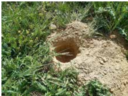
Fig. 3. Hoyado para la colocación del vallado perimetral parcela W
