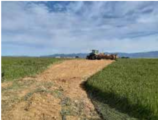
Fig. 1. Desmontes y nivelaciones en parcela W.
