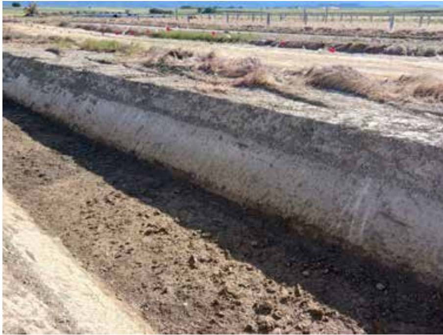
Fig. 3. Zanja del canal principal de drenaje. Parcela E. Detalle de composición estratigráfica del terreno. Depositos de colmatación natural, con abundante materia orgánica, incluyendo elementos de origen antrópico, sobre arcillas y limos.
