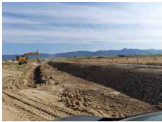
Fig. 2 Colocación de las playas en el final del drenaje hormigonado del drenaje principal interior de la parcela este.
