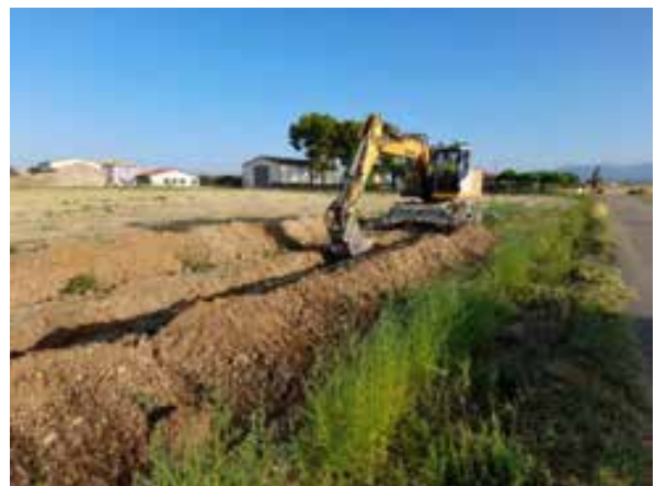
Fig. 2. Apertura de la zanja de media tensión y separación de la tierra vegetal.
