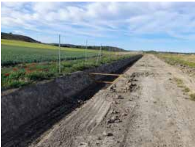
Fig. 2 Apertura de la zanja de la red de drenaje.
