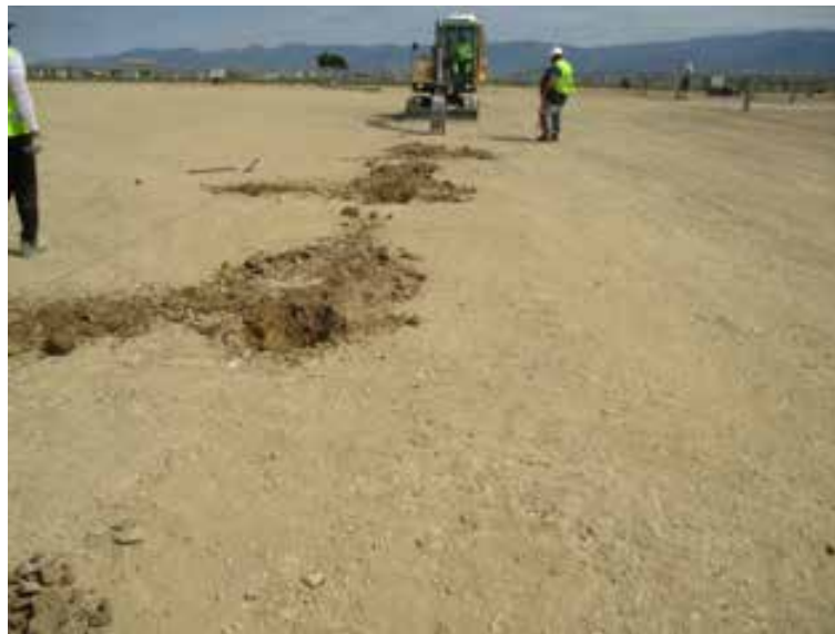
Fig. 3. Control arqueológico durante la excavación de los agujeros de los postes de sujeción del vallado del yacimiento arqueológico
