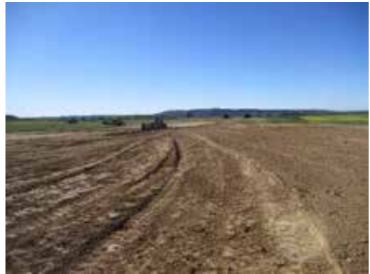
Fig. 2. Desmontes y nivelaciones en parcela W
