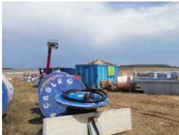
Fig. 1. Maquinaria depositando madera en su correspondiente contenedor.
