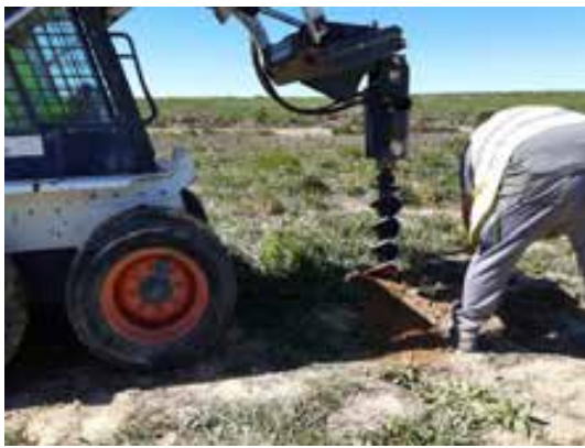
Fig. 1 Instalación del vallado perimetral. Proceso de excavación de los hoyos de los postes.
