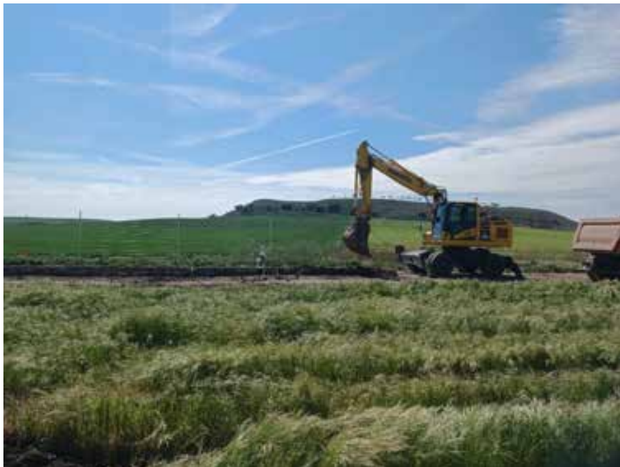
Fig. 2. Zanja del canal lateral de drenaje (tramo 1). Parcela E. Proceso de excavación
