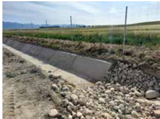
Fig. 1 Colocación de las playas en el final del drenaje hormigonado de la zona sur de la parcela este.
