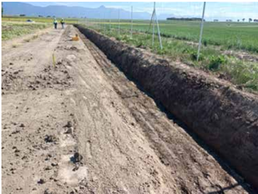
Fig. 2. Zanja de drenaje perimetral de la parcela E
