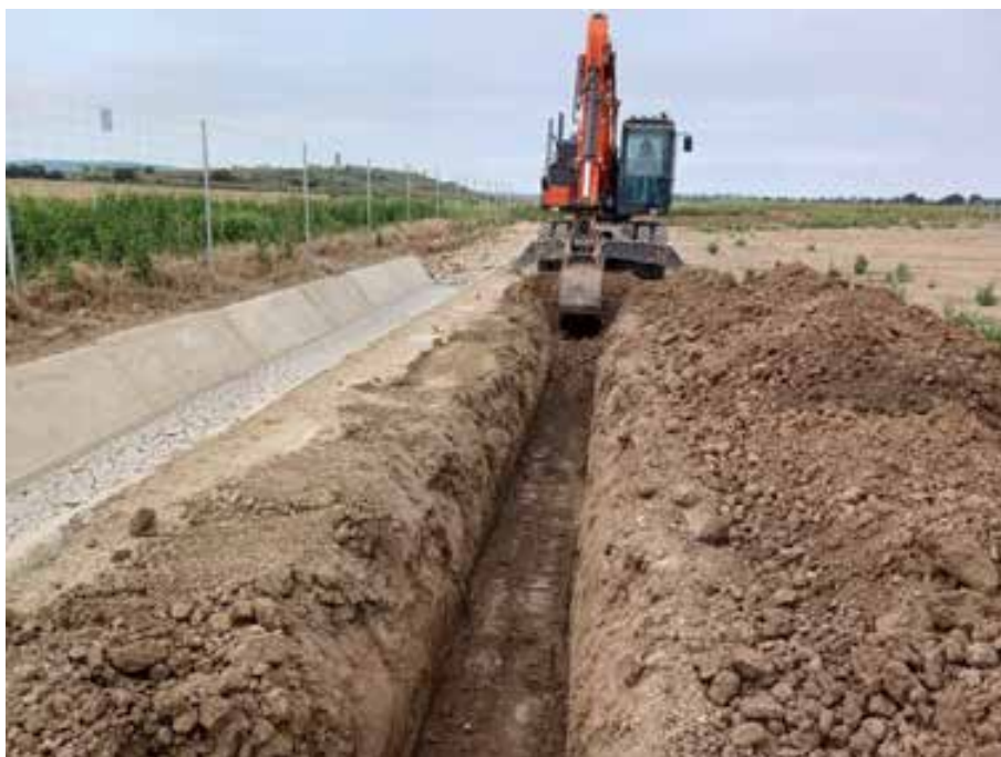
Fig. 2. Control arqueológico en zanja de evacuación eléctrica en parcela E
