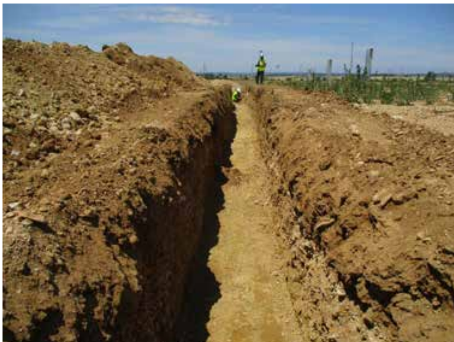
Fig. 2. Control arqueológico en zanja de evacuación eléctrica en parcela W
