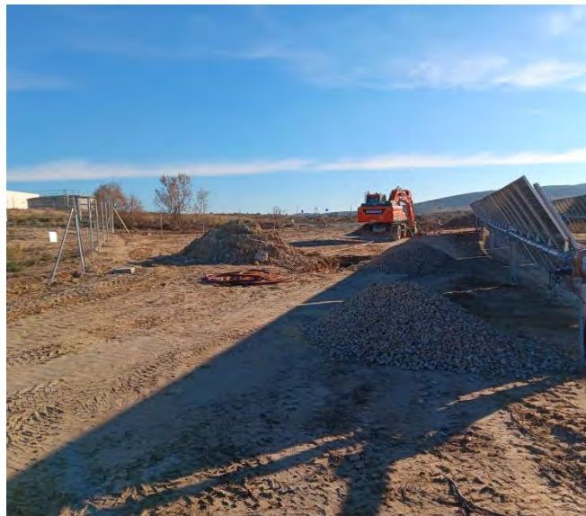
Figura 2: Maquinaria trabajando en construcción de drenaje subterráneo.
