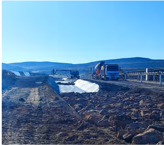
Figura 3: Gunitado de la red de drenaje.
