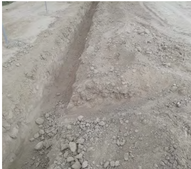
Figura 1: Rampa para salida de fauna en la zanja.
