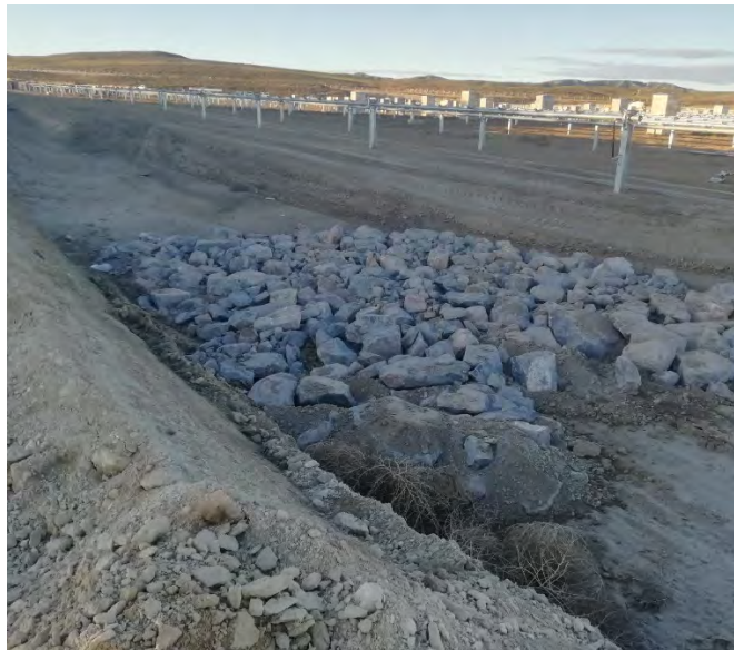
Figura 1: Escollera en el punto bajo de la cuneta.
