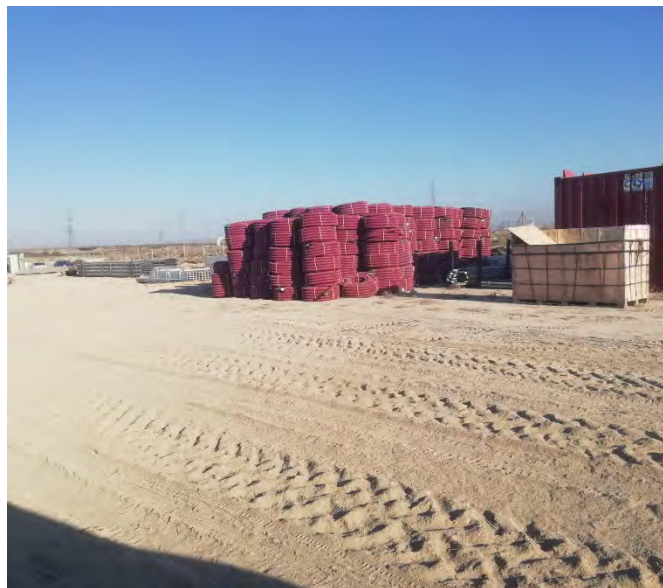
Figura 2: Acopios de materiales de la obra.
