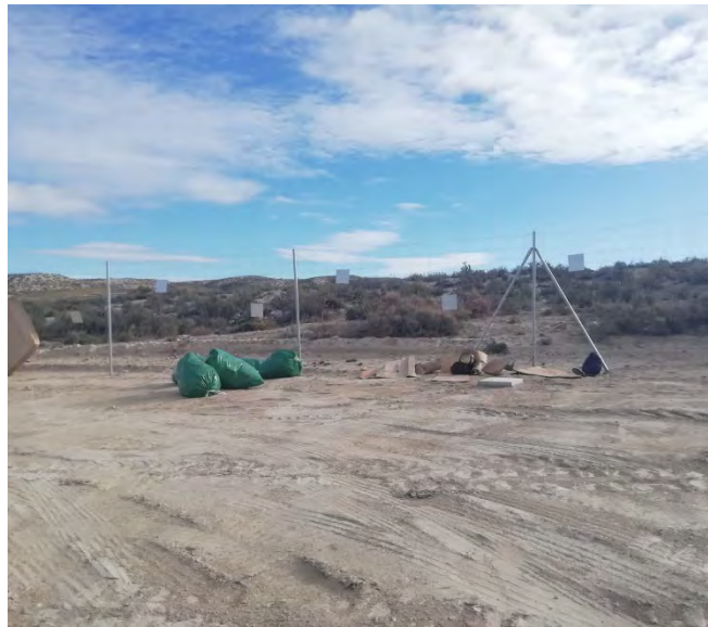
Figura 1: Limpieza de residuos.
