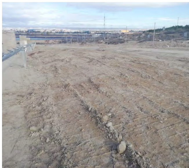
Figura 2: Acopio de tierra vegetal con paso de vehículos por encima.
