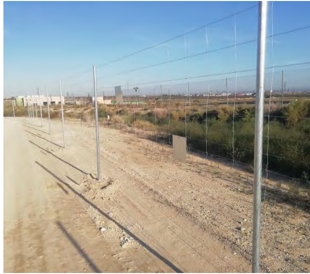
Figura 1: Placas en vallado.
