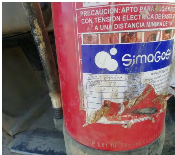
Figura 3: Extintor en maquinaria trabajando en la obra.
