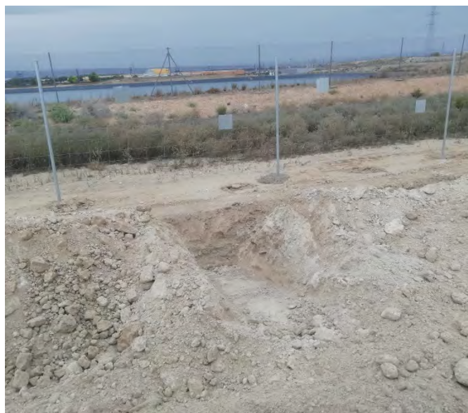
Figura 2: Rampa para salida de fauna en la zanja.
