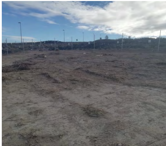
Figura 1: Acopio de tierra vegetal.
