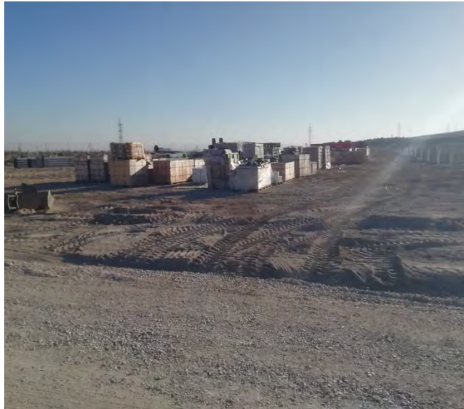
Figura 1: Acopios de materiales de la obra.
