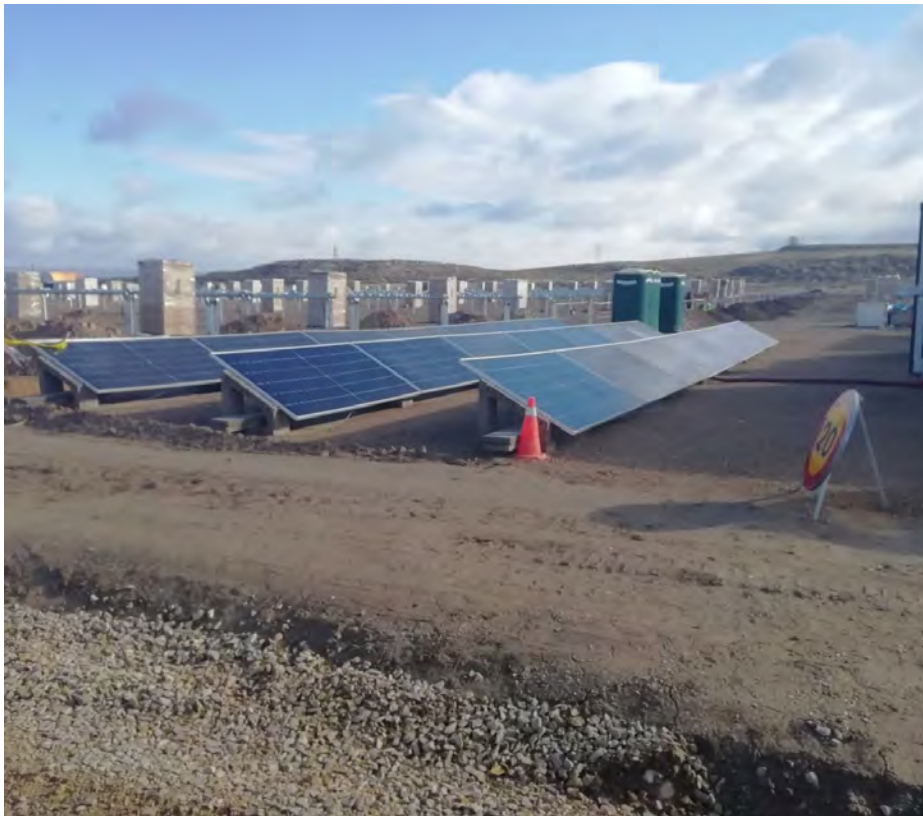
Figura 1: Instalación del huerto solar.
