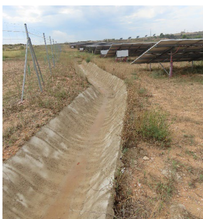
Figura 3. Cuneta hormigonada de aspecto correcto.
