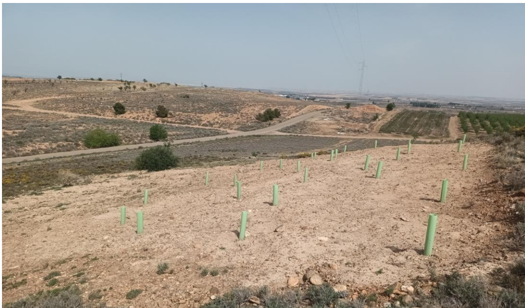
Nueva revegetación efectuada en las proximidades del apoyo 32 de la LAAT, arriba, y estado de las plantas, abajo.
