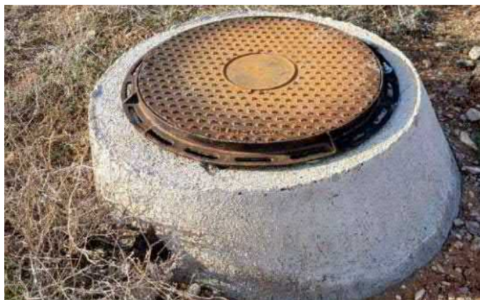
Imagen 1. Estado de conservación de una de las balizas esféricas
