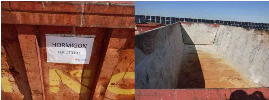
Imagen 24. Contenedor habilitado para el depósito de hormigón adecuadamente identificado
