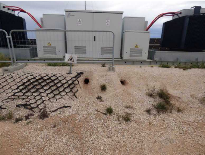
Imágenes 14 y 15. Madrigueras debajo de los inversores y debajo de las hincas del vallado perimetral (imagen izquierda y derecha respectivamente).
