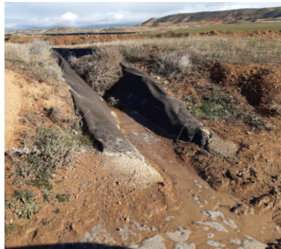
Drenaje exterior con arena y barro seco en octubre, y el mismo drenaje en diciembre después de un día de lluvia.
