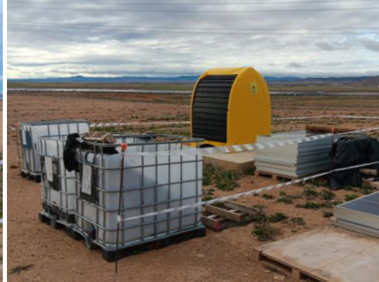
Contenedores señalizados y aislados del suelo.
