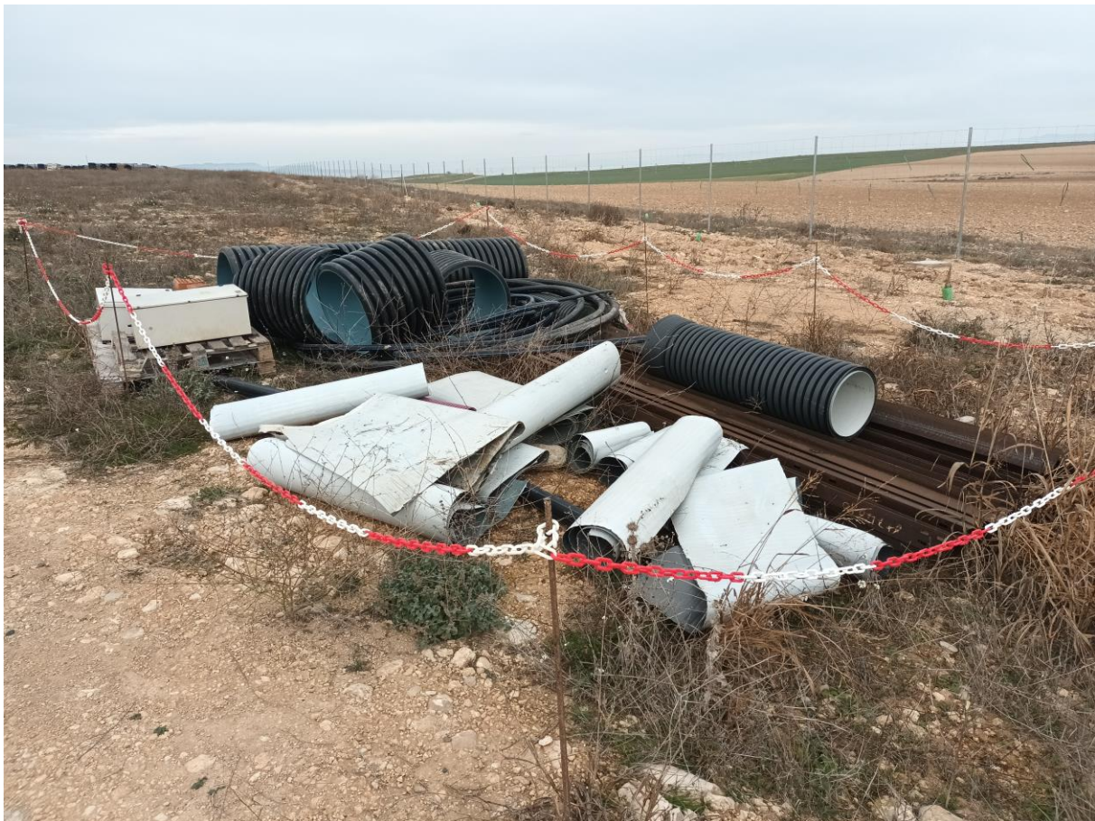
Residuos resultantes de la obra que durante este período trimestral han sido acopiados y retirados.
