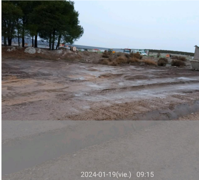
Ilustración 2. Piscina de hormigón de la parcela 1 vaciada y correctamente tapada
