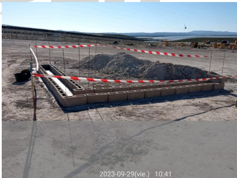
Ilustración 23: balizado construcción primillar
