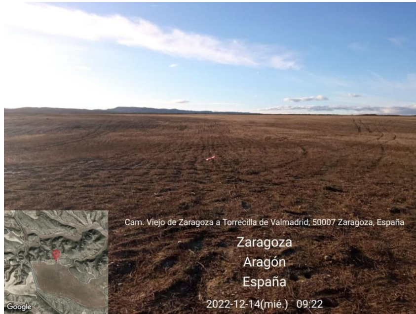
Ilustración 2: estaquillado adecuado zona obras
