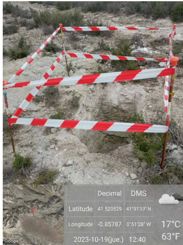
Ilustración 25: balizado adecuado del agujero realizado para la colocación del posadero para avifauna de las medidas compensatorias
