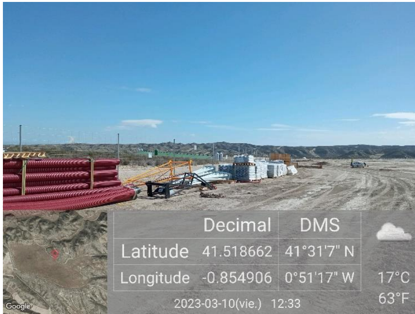
Ilustración 9: acopio material obra
