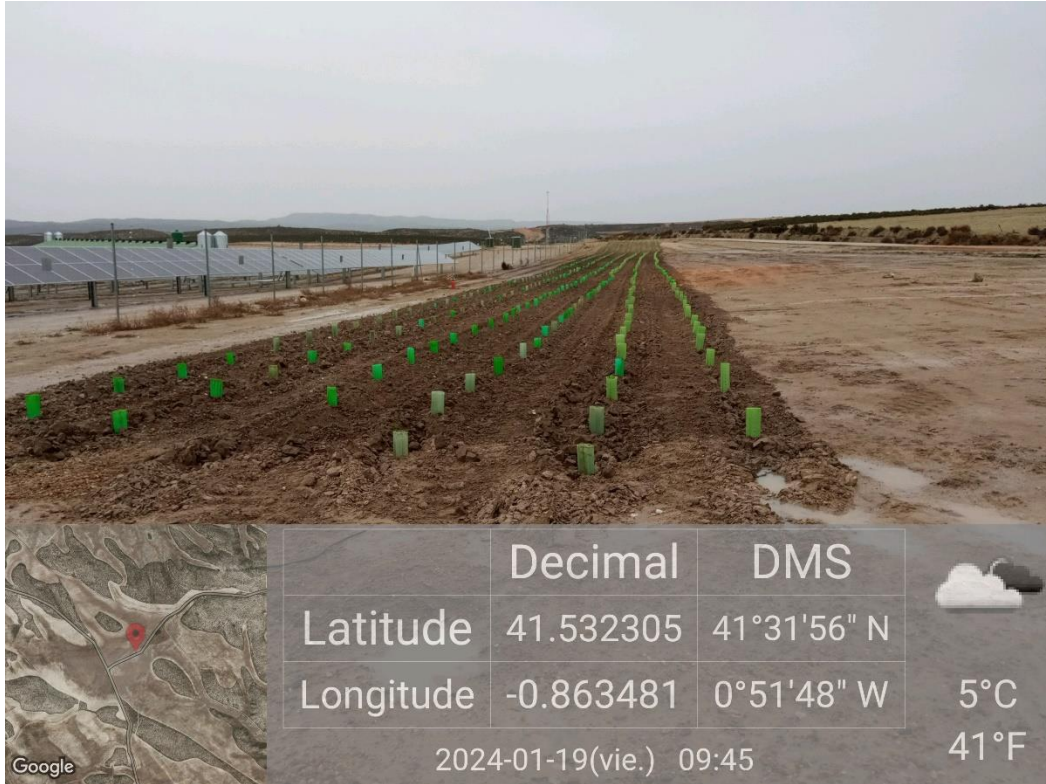
Ilustración 32: instalación de la pantalla vegetal
