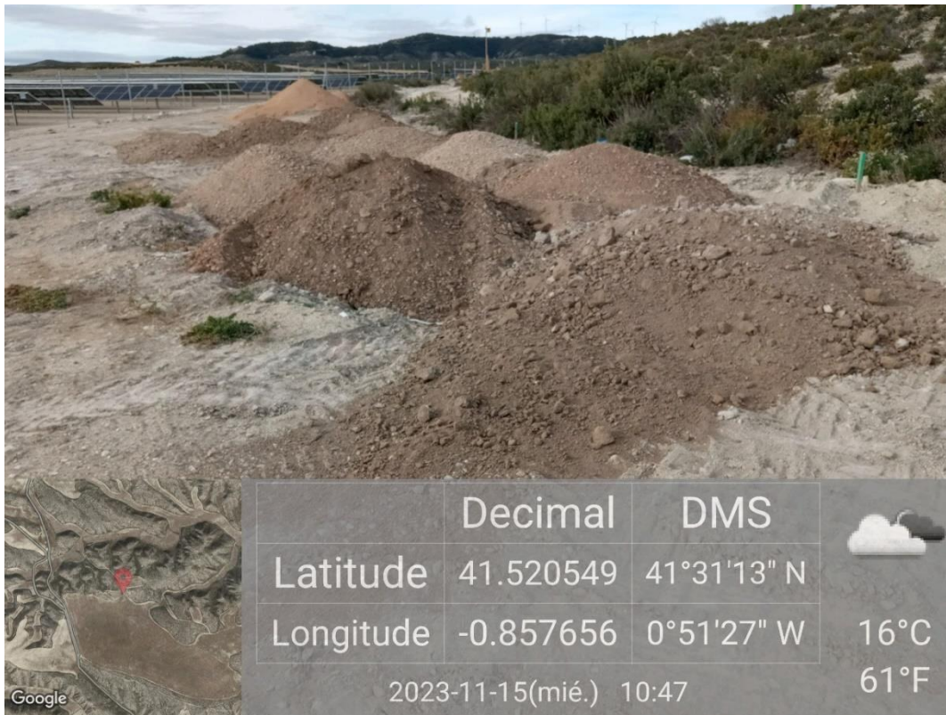
Ilustración 27: acopio de tierra vegetal siguiendo los requisitos de la DIA
