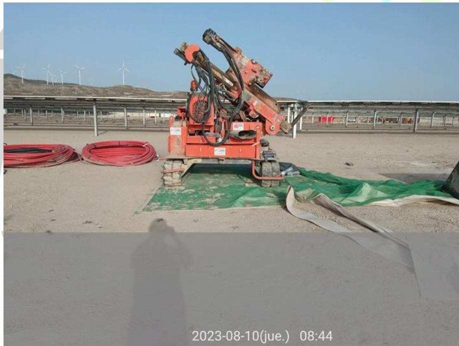
Ilustración 21: máquina de obra con plástico bajo ella para prevenir vertidos
