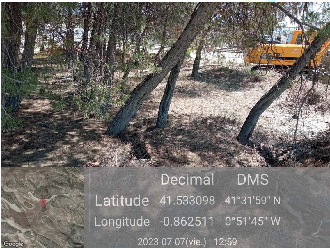
Ilustración 19: limpieza efectiva zona de acumulación de Residuos No Peligrosos sobre vegetación natural
