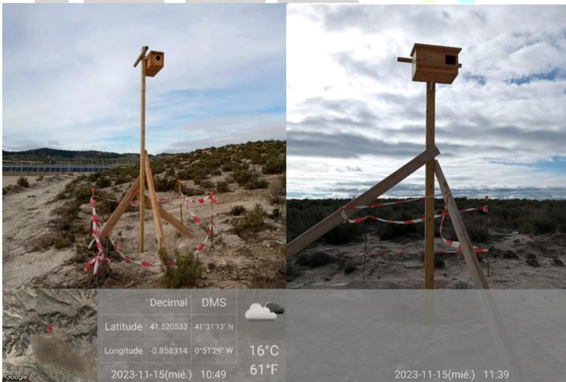
Ilustración 28: Construcción e instalación de cajas nido - posadero
