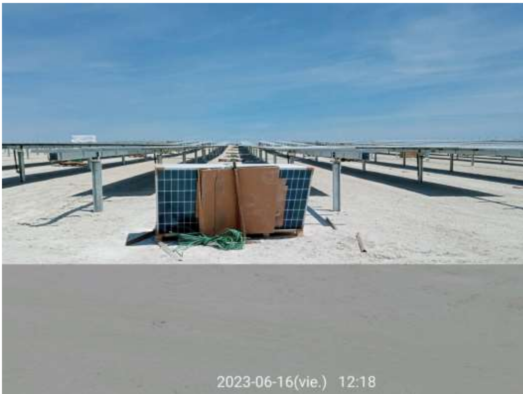
Ilustración 9. Material de embalaje de colocación de placas ordenadamente acopiado para su recogida posterior al punto limpio.
