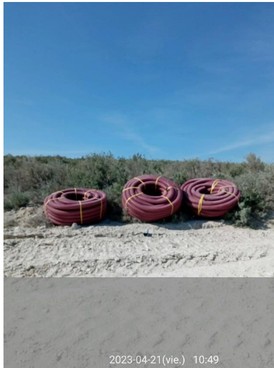
Ilustración 4. Material de obra acopiado en vegetación natural.
