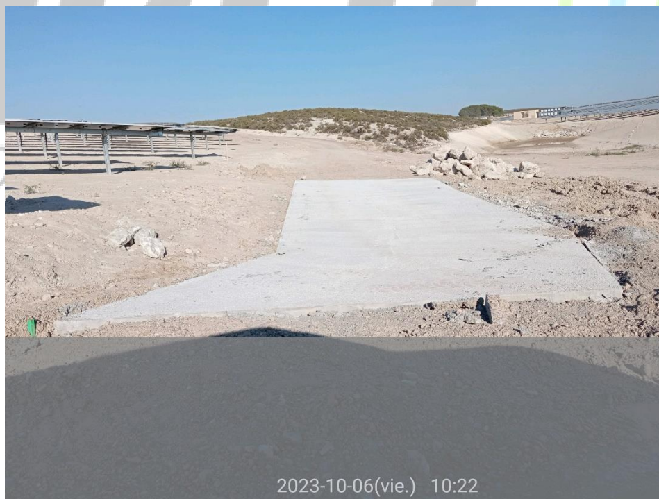
Ilustración 2. Zona con erosiones importantes correctamente hormigonada para evitar mayores impactos por la lluvia.
