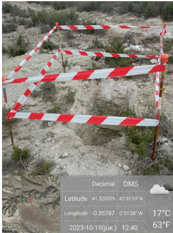
Ilustración 4. Agujero para colocación de caja-nido/posadero en la parcela 3.
