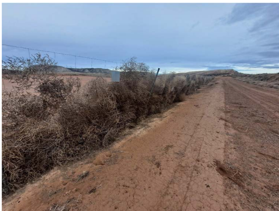
Figura 8.2. Acumulación de vegetación en un tramo del vallado (límite sureste de la parcela), a fecha 15-01-24
