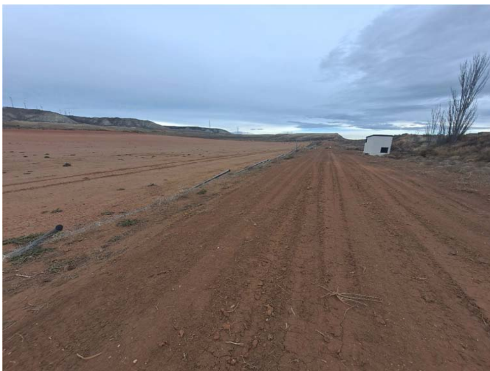
Figura 8.1. Tramo del vallado doblado (límite sureste de la parcela), a fecha 15-01-24
