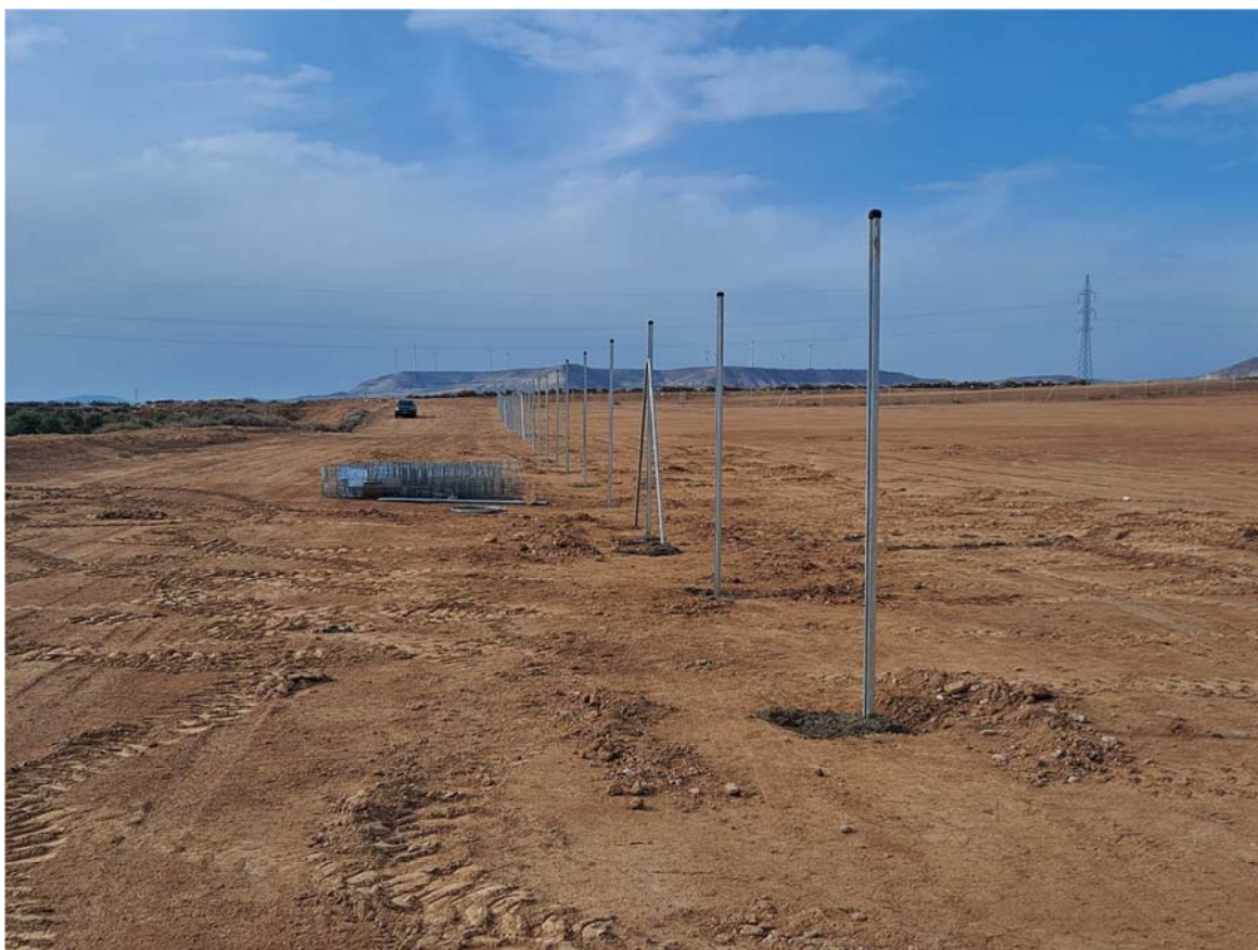
Figura 4.1. Instalación de nuevos postes para el vallado en los límites NW y SE del recinto de la planta
