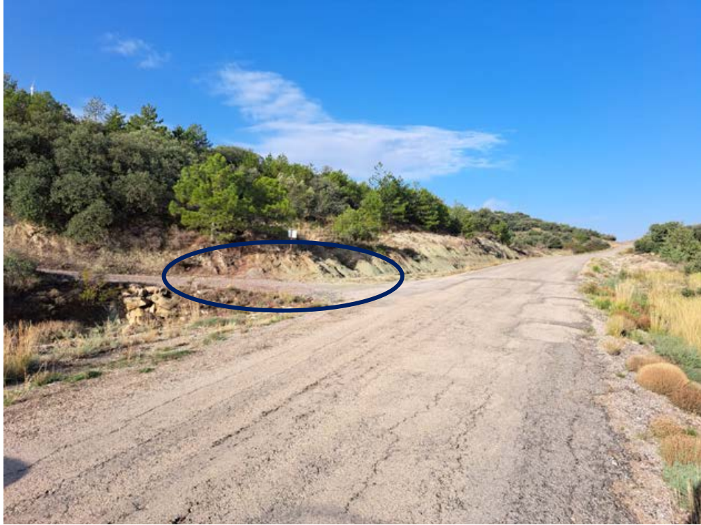
Foto 5. Vista de la zona de incorporación a la carretera Te-V-1010 desde las zonas 2 y 3 de explotación
