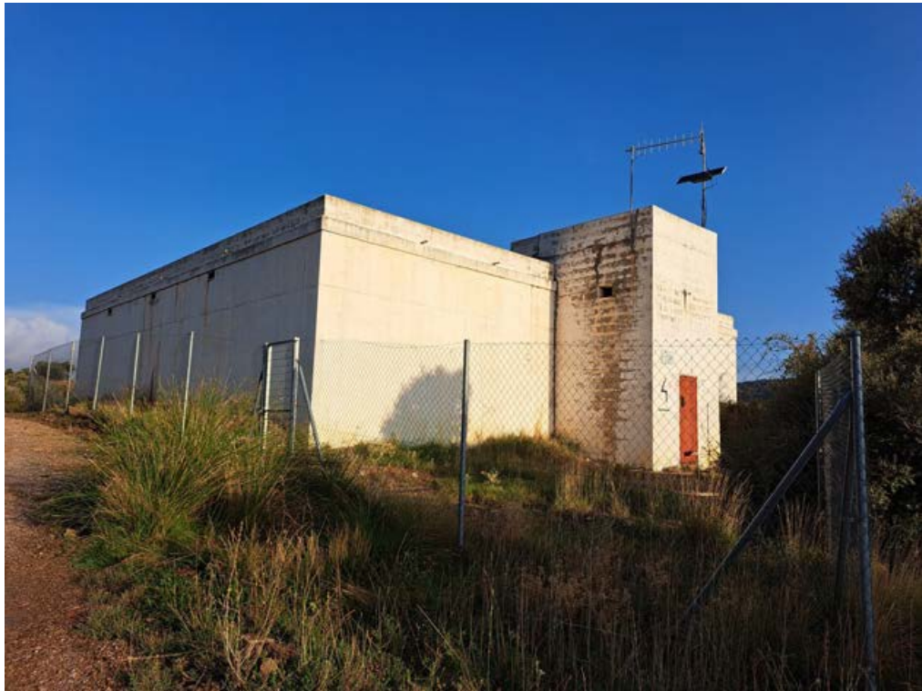
Foto 19. Depósito de aguas nº 4 de abastecimiento a Utrillas, donde llega la tubería que está trazada sobre el camino de acceso a la explotación.
