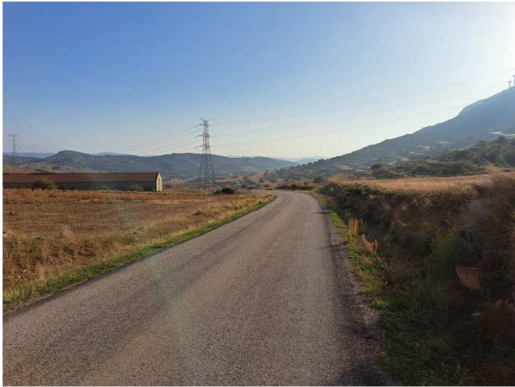
Foto 17. Tendidos eléctricos procedente de la evacuación del parque eólico que cruza la carretera Te-V-1010.
