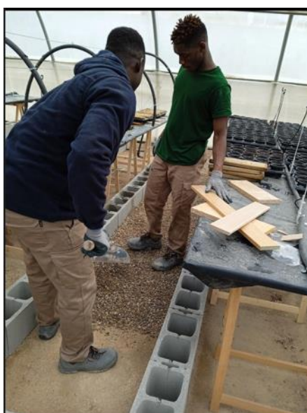
Vertido de grava en suelo de invernadero para evitar humedades
