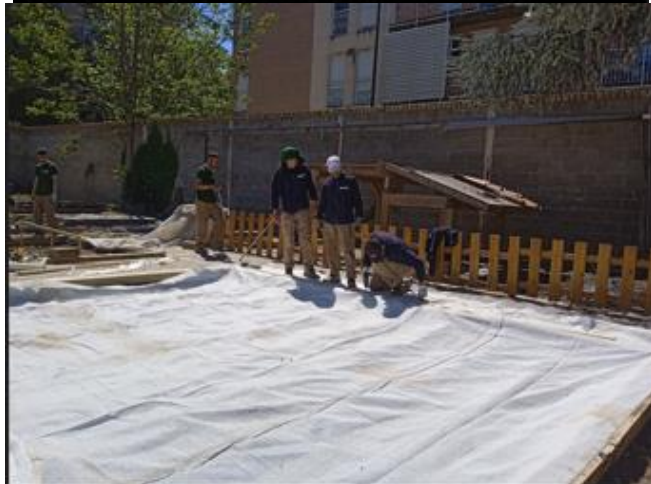
Instalación de riegos localizados y mallas de sombreo para invernaderos.
