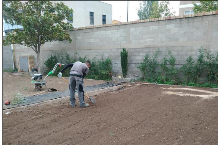
Preparación del lecho de césped (Nivelación del terreno y enmienda física/biológica)
