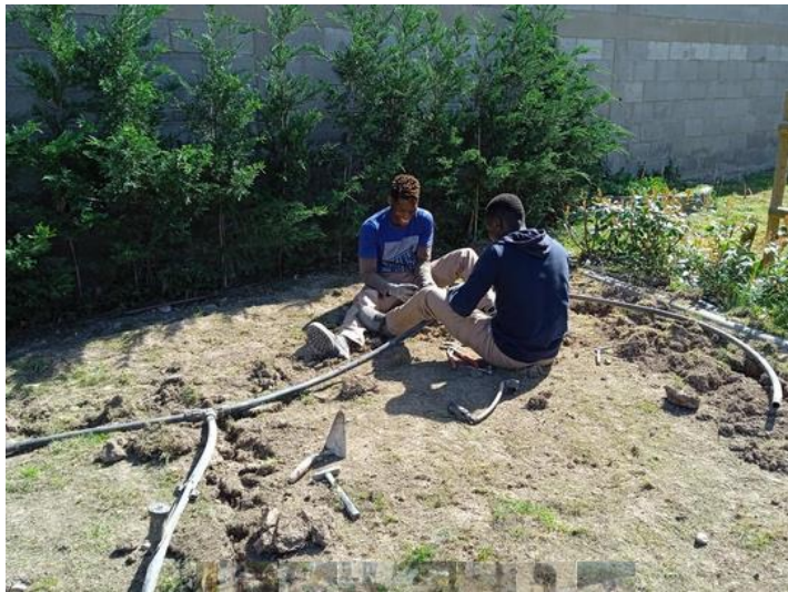
Instalación de riego superficie Aspersor/ Difusor
