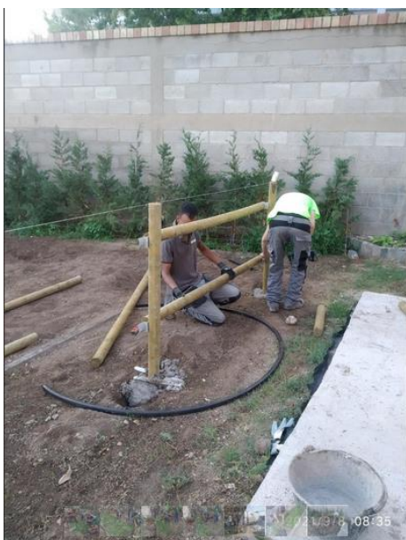
Instalación y replanteo de barandilla de madera
