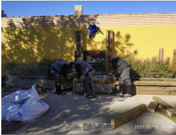
MANTENIMIENTO DE GAVIONES Y JARDINERAS.
