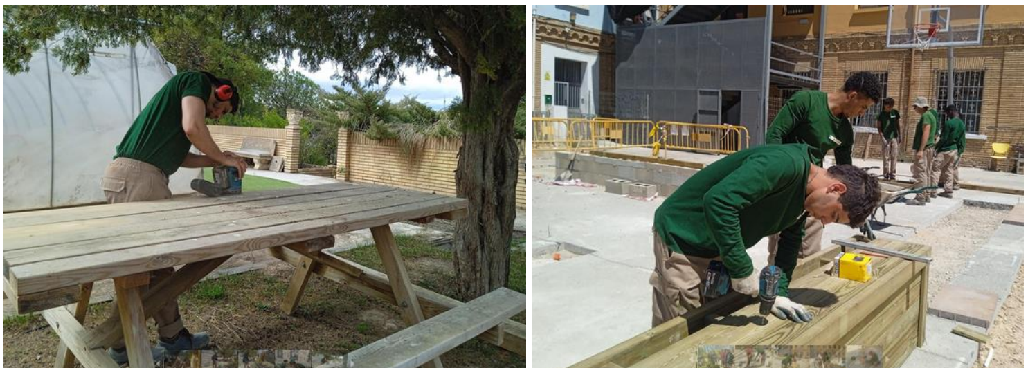
Obra proyecto MANTENIMIENTOS CORRESPONDIENTES A MOBILIARIO URBANO. CAMBIO DE MATERIAL, REVISION TORNILLERIA, BARNIZADO, LIJADO
