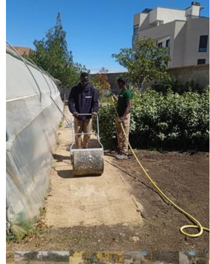
Construcción de viales (losa adoquín/arena de andador)
