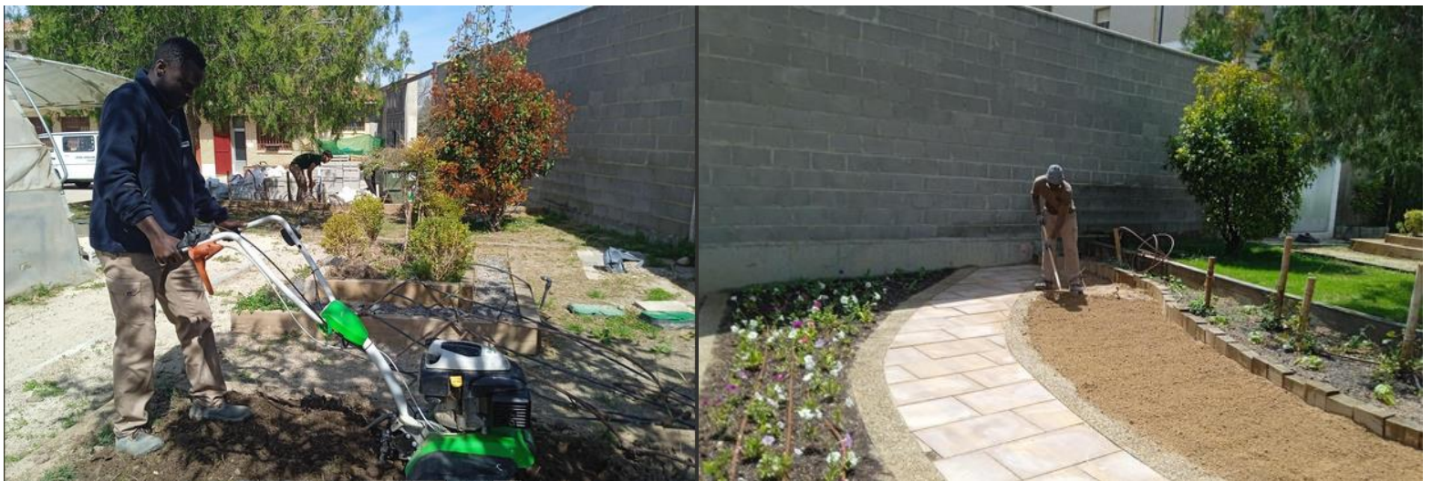
MOVIMIENTOS DE TIERRA CON MOTOAZADAS Y PERFILADO DE TIERRAS
