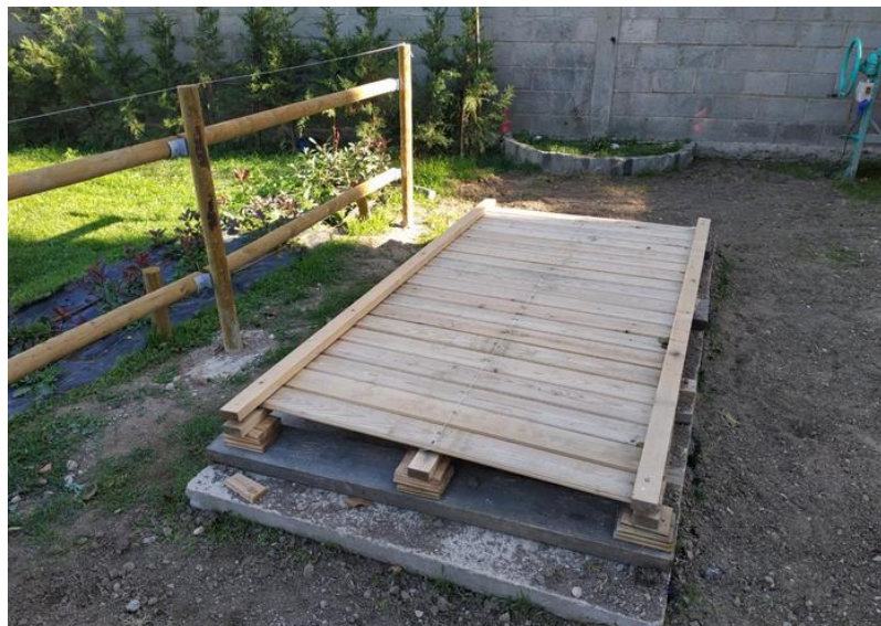
Construcción de solera e instalación de tarima.
