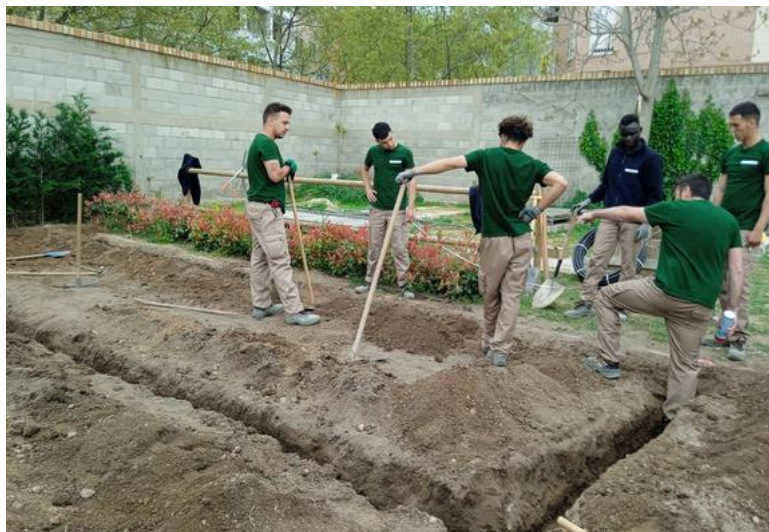
Realización de zanjas para las tuberías generales.
