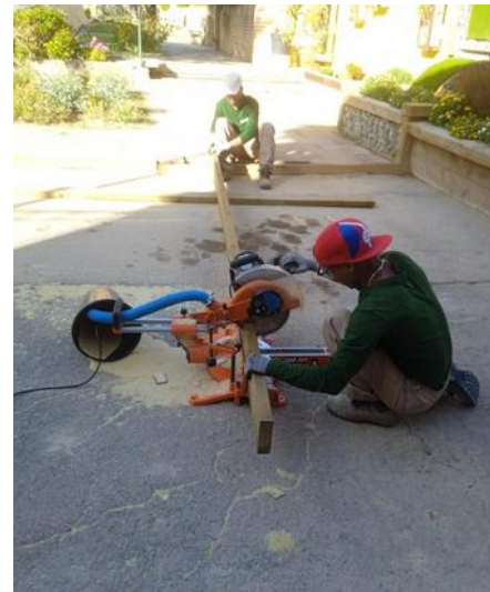
Construcción de bordillos (bordillo jardinero cemento in situ /madera traviesa)
