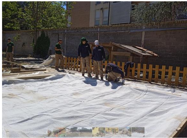
Instalación de malla anti-hierba
