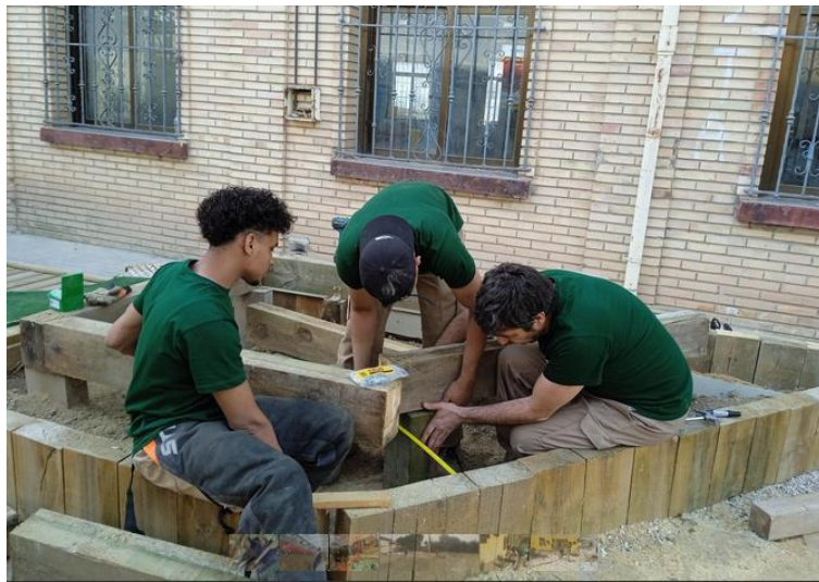
Construcción de jardineras con estructuras de madera
