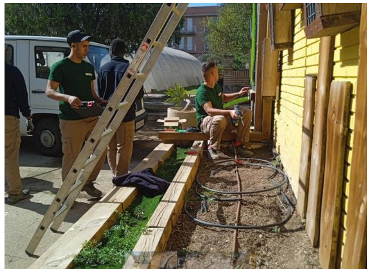
Arreglo de averías de riego gotero integrado
