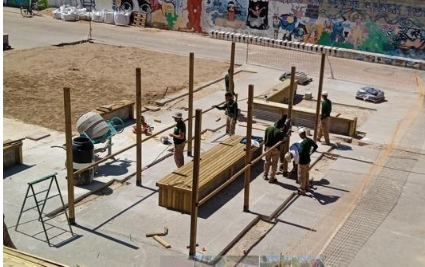
Construcción bancos con estructuras de madera (obra proyecto)
