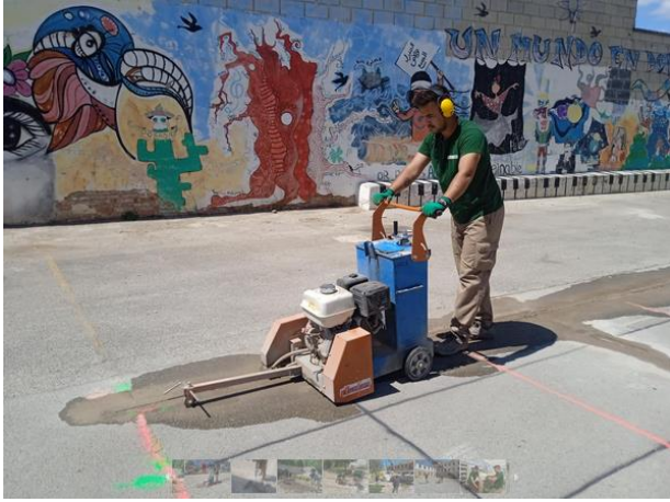
Usando distintas herramientas de corte ( cortadora de asfalto) - pistolete – radial de corte
