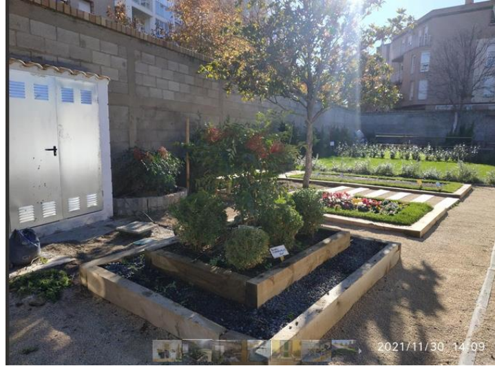
CONSTRUCCIÓN DE JARDIN SOBRE CUBIERTA O TECHO.
