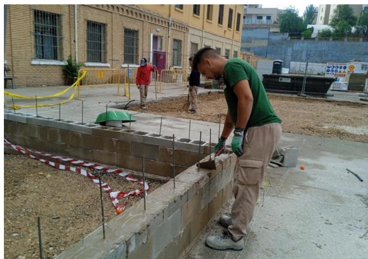
Construcción de muro de bloque de hormigón (obra proyecto)
