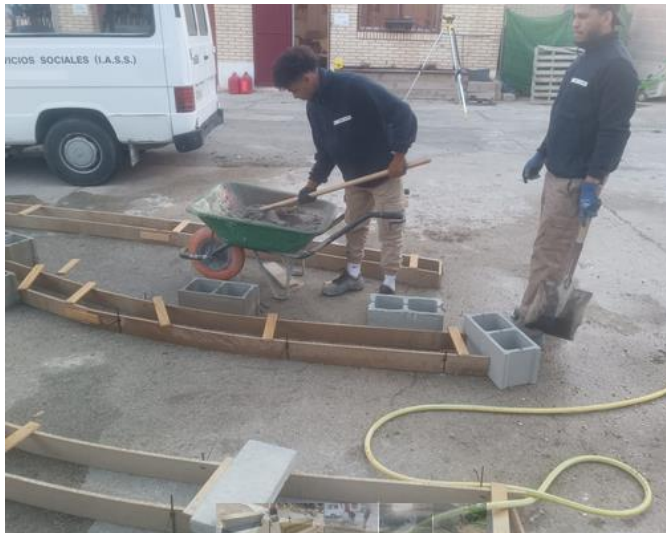
Construcción de bordillos (bordillo jardinero cemento in situ /madera traviesa)
