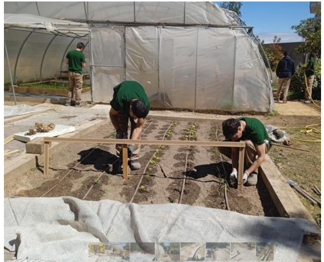
Instalación de riego localizado gotero
