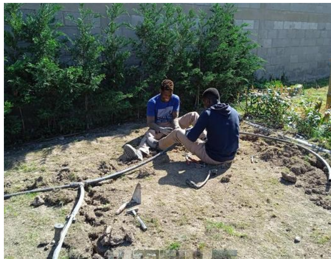
Arreglo en tuberías y apertura de zanja con la profundidad deseada
