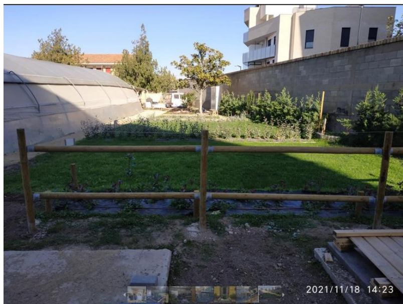
Instalación y replanteo de barandilla de madera
