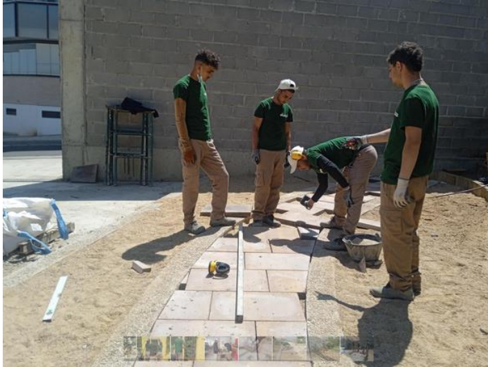
Construcción de viales (losa adoquín/arena de andador)
