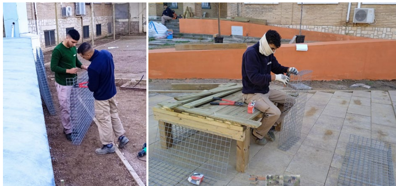
CONSTRUCCIÓN DE ARMAZON DE BANCO Y JAULA DE GAVION
