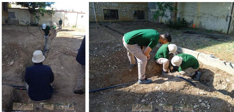
INSTALACION DE RIEGO DE DISTINTAS ZONAS ( RED DE ASPERORES EN ZONA DE PRADERA)
