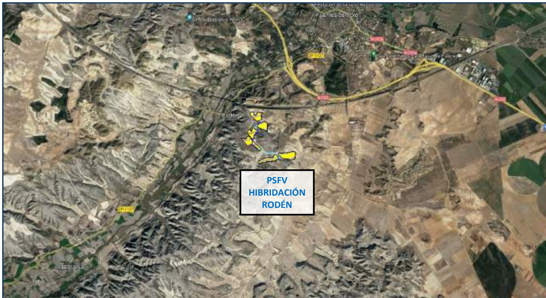
Recreación paisajística 2. Vista aérea general del entorno de la Planta Solar Fotovoltaica "Hibridación Rodén" al sureste de Fuentes de Ebro, junto a la N-232.
