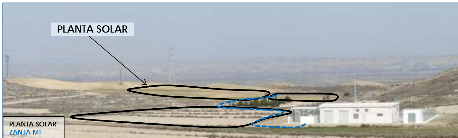
Fotografía 2. Detalle de la zona próxima a la SET.
