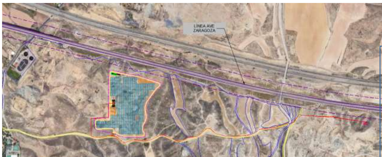
Figura 10: AVE Zaragoza- Barcelona.
