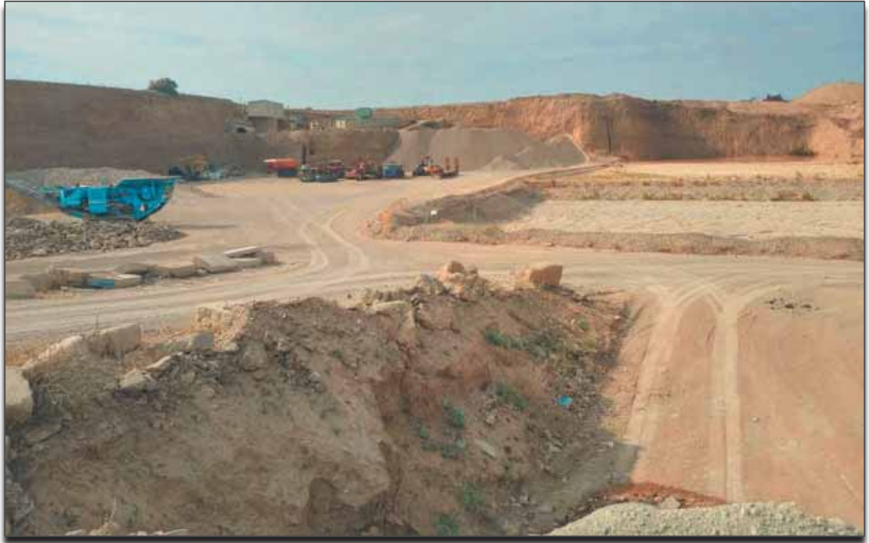
Figura nº 2. Vista de la zona de instalaciones (Fecha: mayo 2023).
