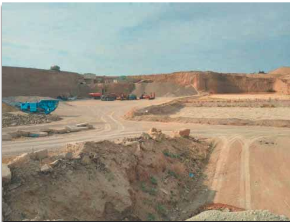
Figura nº 3. Vista de la zona de instalaciones (Fecha: mayo 2023).
