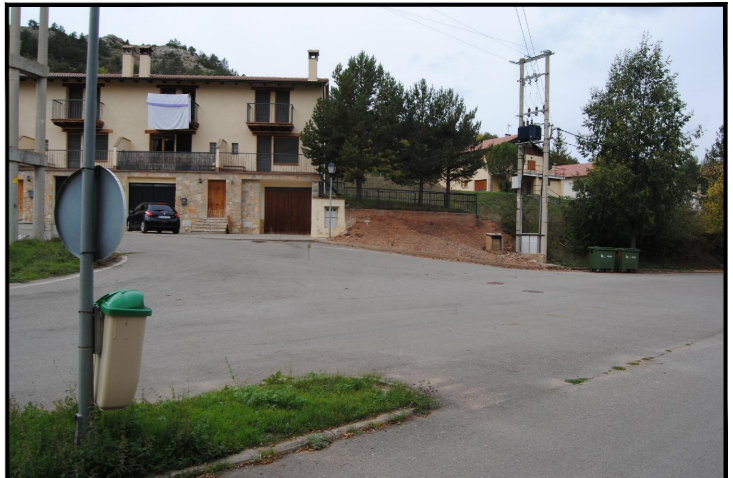
Red eléctrica en media tensión en aéreo y apoyo con soterramiento de la red. Encuentro de camino linares con camino campo de golf.
