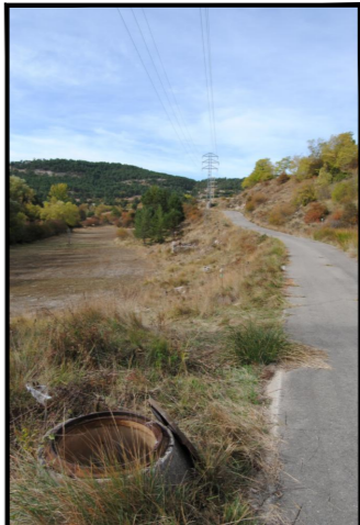
Pozo existente, apoyos y red eléctrica en media tensión.
