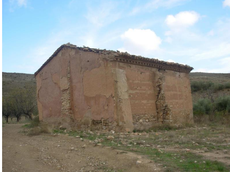
Foto nº 1: Vista exterior de la Ermita de San Félix
