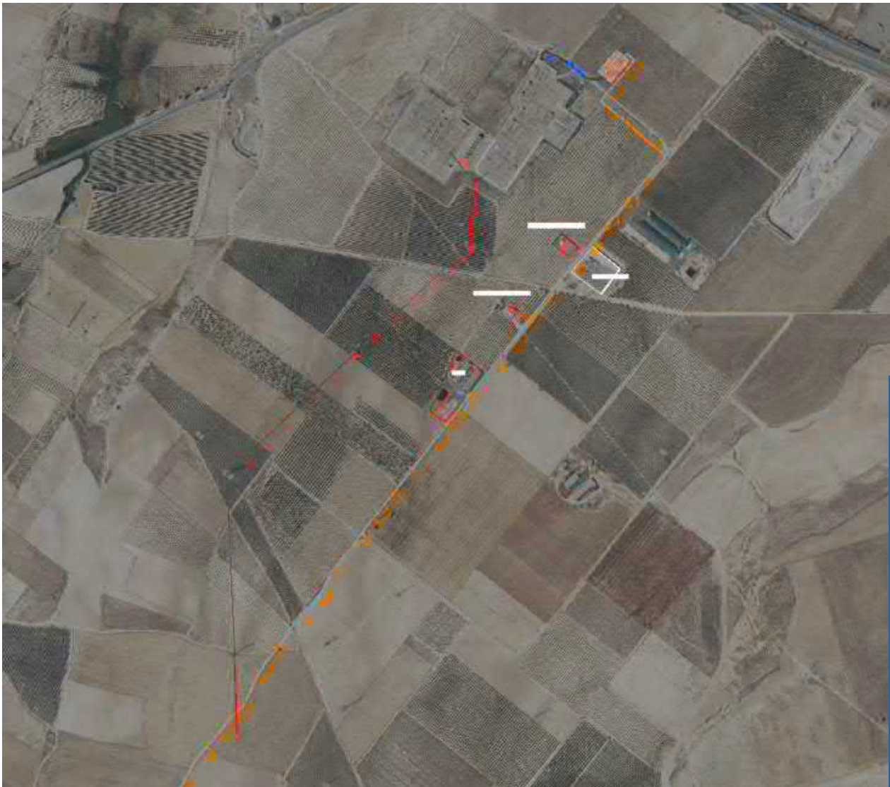
Figura 15: Cruzamiento línea eléctrica 400 kV
