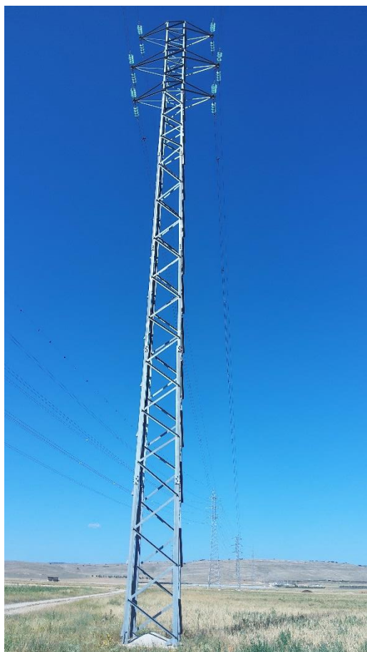
Apoyo 12D existente de la Línea aérea 20 kV ST_E_CELLA
