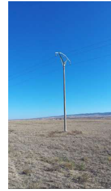
Apoyo 18 existente a sustituir
