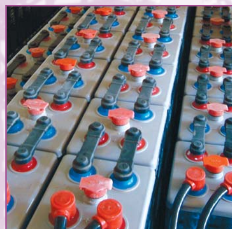
Asociación de baterías. Instalación fotovoltaica aislada en vivienda (Huesca)
