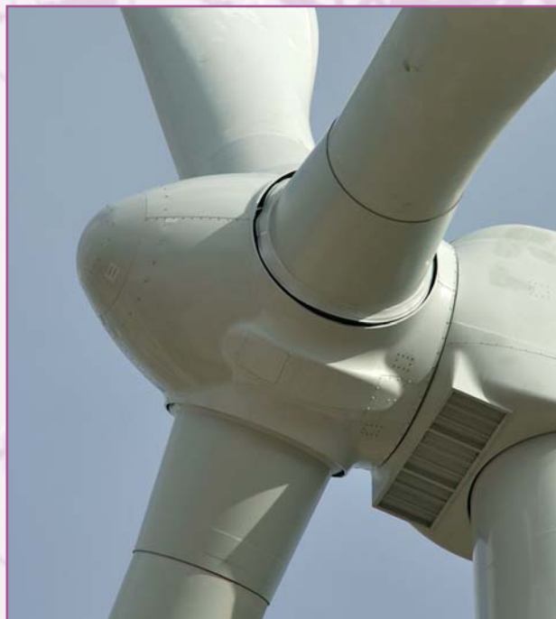
Buje del aerogenerador de 4.5 MW (Jaulín, Zaragoza)
