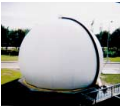
Gasómetro de doble membrana.
