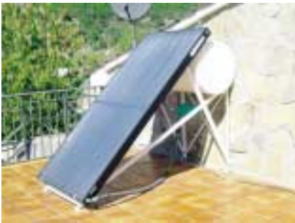
Colector para agua caliente.
