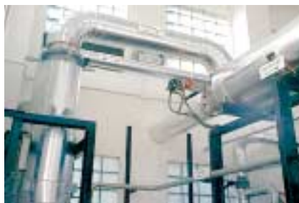
Intercambiador para el aprovechamiento del calor de los gases de escape.
