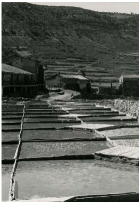
Figura 77: Heras (donde cristaliza la sal) y plataformas donde se apila después de cosechar. Fuente: Reales Salinas de Arcos de Salinas
