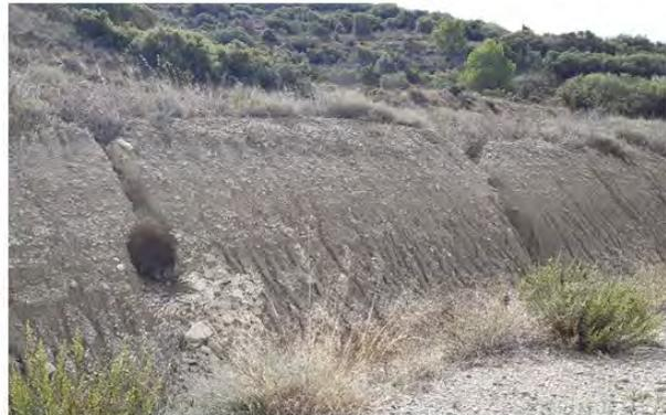
Fig. 12 Erosión hídrica en materiales margosos del talud de desmonte del vial de acceso al aero LSA.02. Fuente: Elaboración propia
