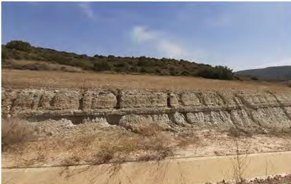
Fig. 11 Erosión hídrica en materiales margosos del talud de desmonte del vial de acceso al aero LSA.07. Fuente: Elaboración propia
