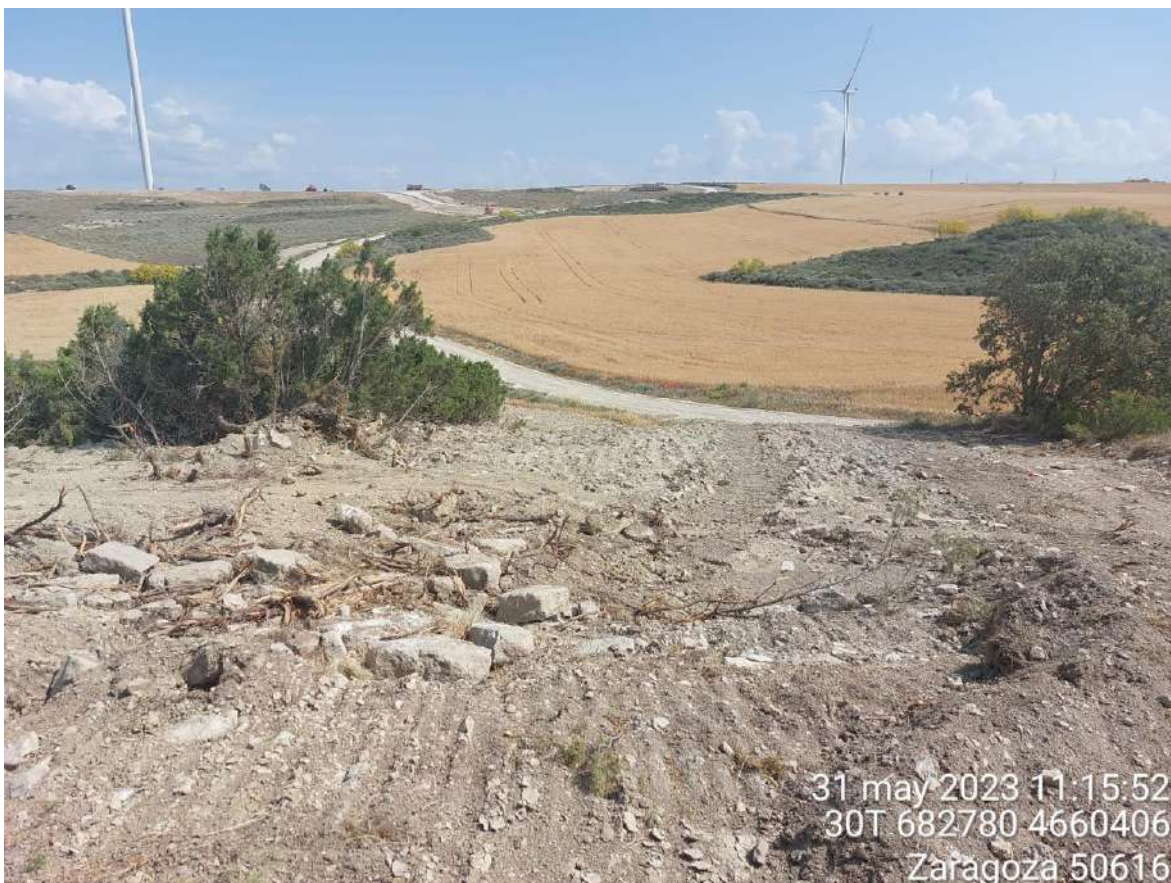
Imagen 2. Tramo de la zanja de evacuación tras relleno, pero sin restaurar definitivamente. Se deben retirar piedras y bolos de tamaño considerable.
