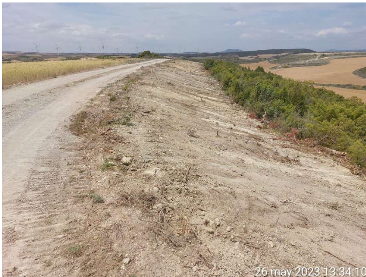
Imagen 2. Relleno de zanja de evacuación sobre el que hay que realizar trabajos de restauración.
