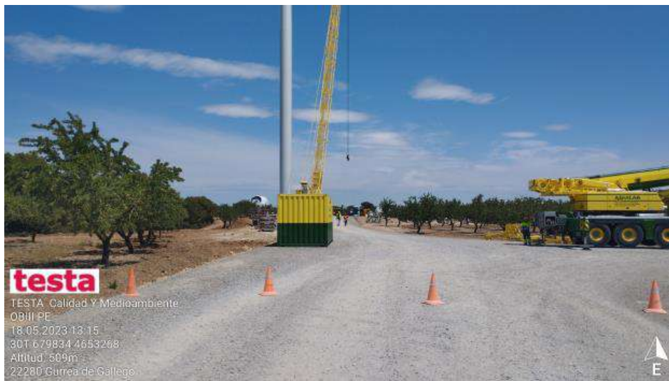
Trabajos en OB2-3
