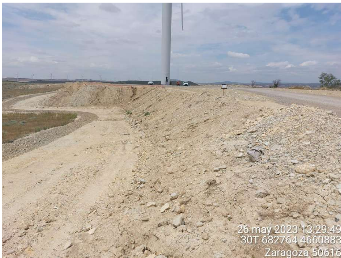
Imagen 1. Posición OBIII-02 en proceso de restauración.
