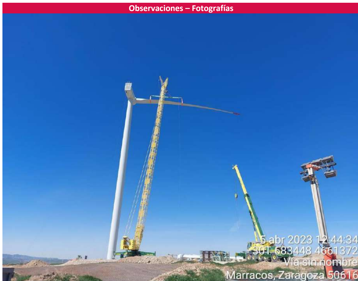
Imagen 2. Montaje de la posición OBIII-01.
