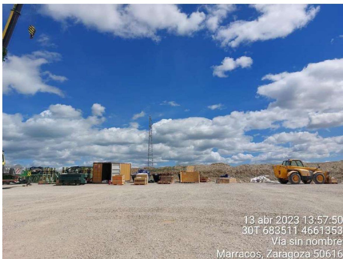
Imagen 1. Punto limpio de NORDEX.
