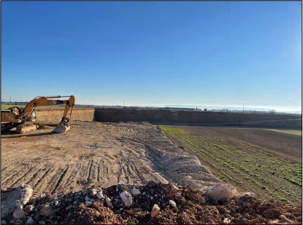
**Figura nº 8.** Vista de la operación. Se observa lo indicado en la memoria. Bancos de operación de 4 metros para llegar a los bancos finales diseñados.
