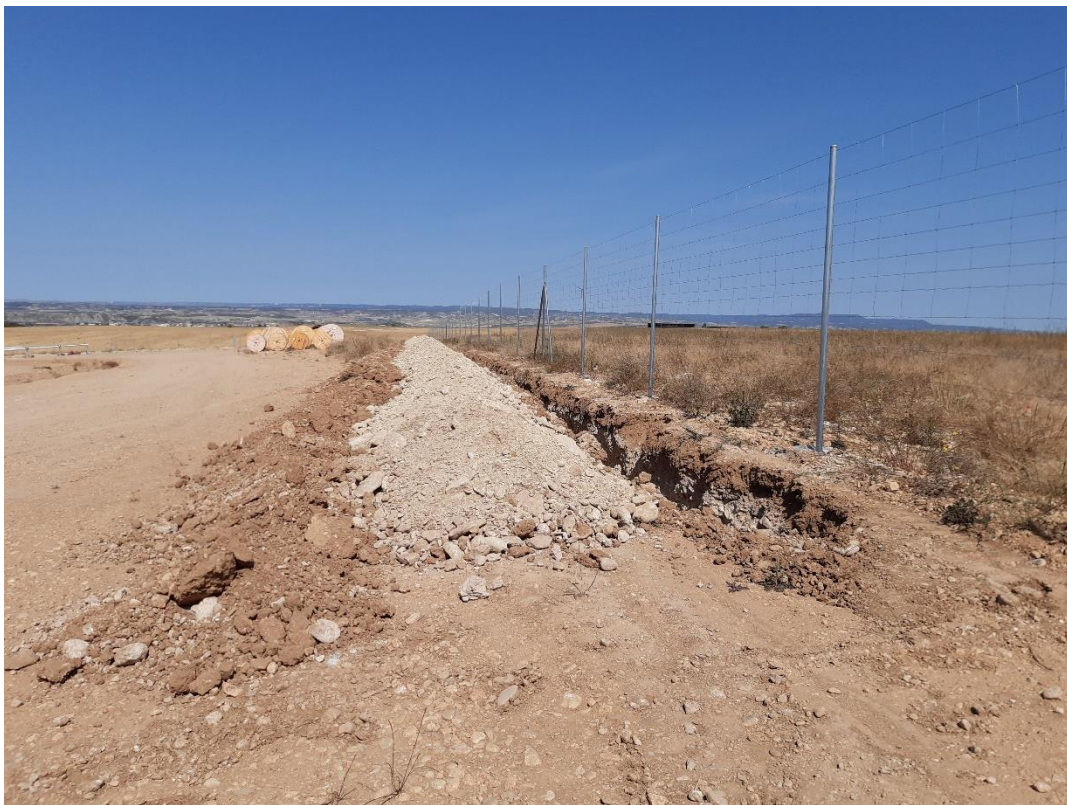
Mapa 1 Trabajos de apertura de zanja
