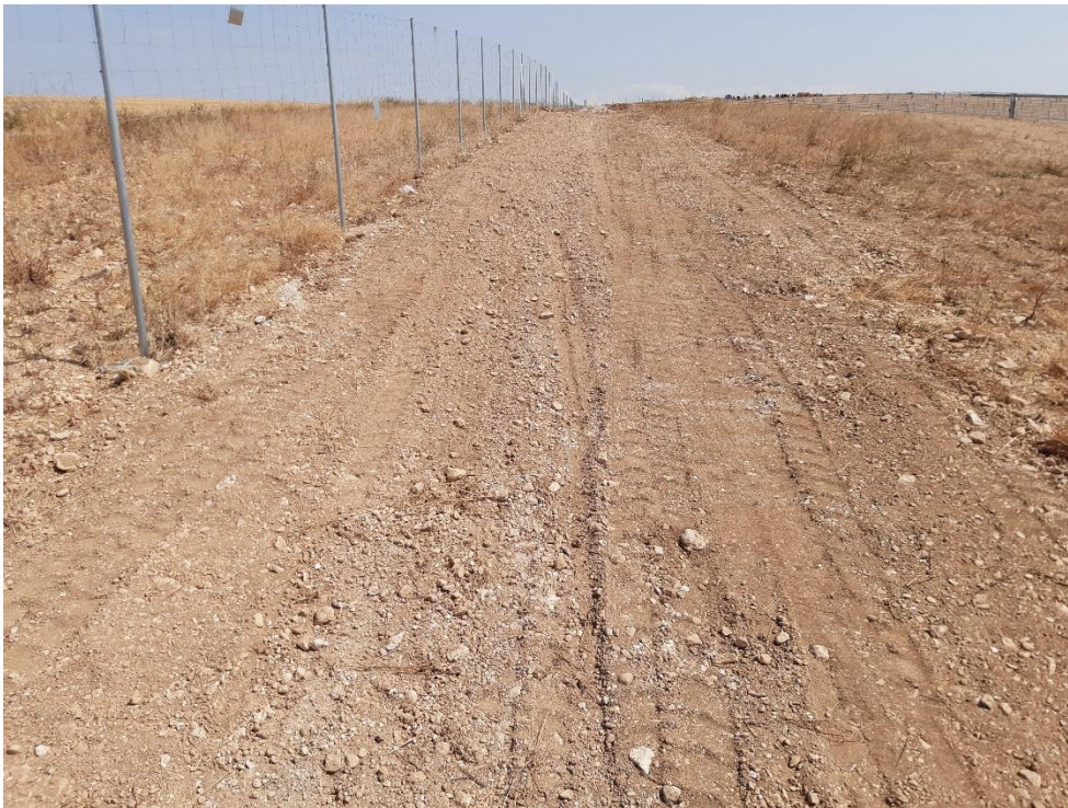
Fig. 1 Zanja de media tensión con tierra vegetal
